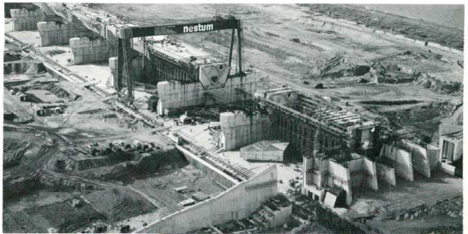
3b Bouw Haringvlietsluizen foto: KLM-Aerocarfo
