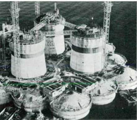
3a Beryl-platform in uitvoering
