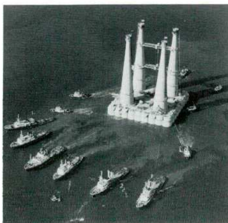
1b Het Andoc-platform, onder weg van de Maasvlakte naar een diepe bouwplaats in Noorwegen foto: Aerocamera
