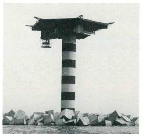
5b Lichttoren geplaatst in Europoort foto: Jack van Bodegom
