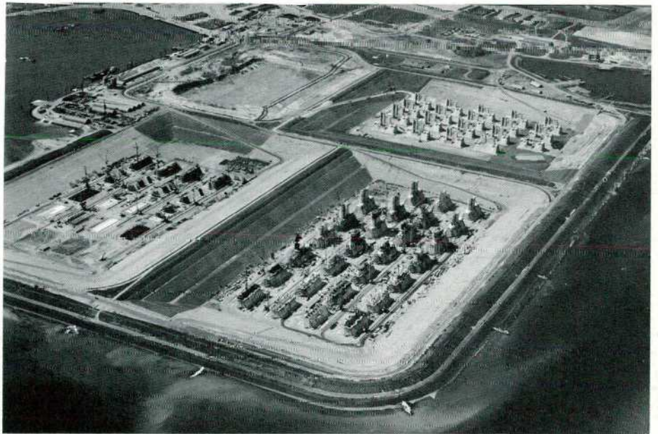
11 Bouwput verdeeld in vier compartimenten foto: Aerocamera
