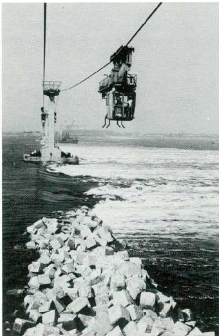
6 Kabelbaan voor blokkentransport ten behoeve van afsluiting zeearmen foto: Waterstaat
