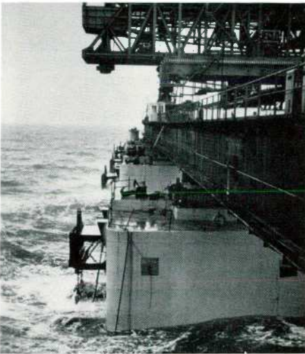
2b Betonnen pijlers uitgevoerd als caissons dragen een grote kraanbaan voor het laden van schepen
