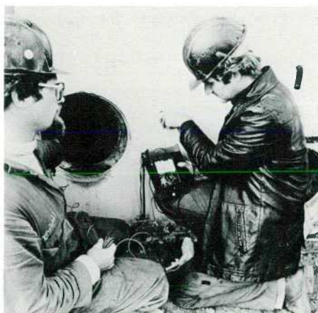
15 Controlemeting elektrische weerstand ankerbout
