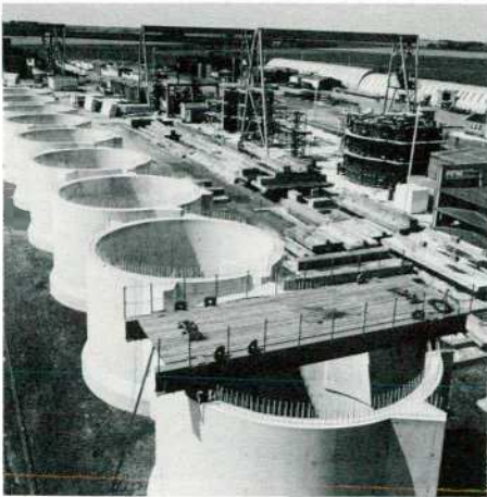
9 Funderingsringen voor landhoofden foto: Waterstaat
