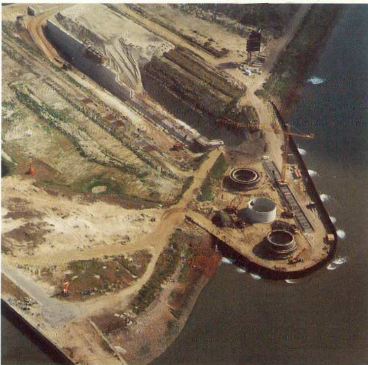
Luchtopname van de bemalingsinstallatie t.b.v. de pierconstructie van de Berendrechtsluis.
