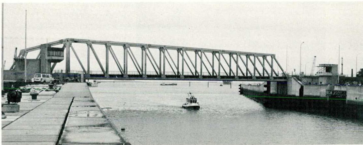
De basculebrug aan de Scheldekant van de Berendrechtsluis.
