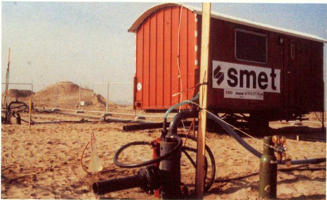
Detailopname van de retourbemalingsinstallatie ter hoogte van BRC.
