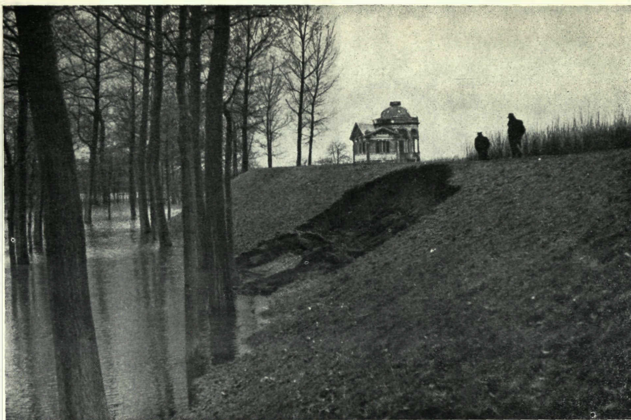
Deze foto toont duidelijk het mechanisme van de dijkdoorbraken in het Scheldebekken. Ingevolge het abnormaal hoogtij stijgt het water tot aan de kruin van de dijk, vindt hier en daar een gunstige overloop en vloeit over de dijk. Wanneer dit overlopen een zekere tijd aanhoudt, geraakt het binnenbeloop van de dijk doordrenkt en verliest zijn cohesie. Het doorsijpelende water sleept eerst de kleinste deeltjes mee en naarmate de helling steiler wordt, ook de grotere deeltjes. Weldra schuift volgens een holrond vlak een gans stuk van de dijk. Houdt het overlopen nog aan dan kan de dunner geworden dijk begeven en er ontstaat een breuk.
