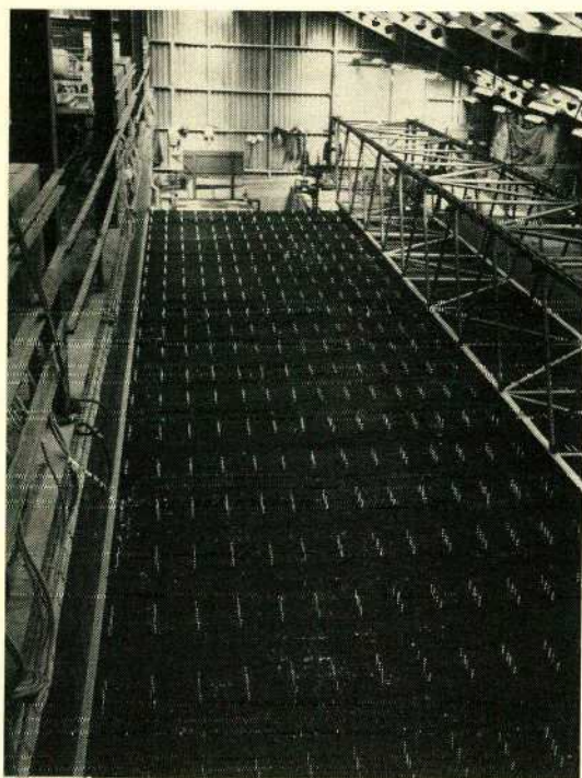
La toile en polypropylène de 30 m de largeur étalée dans l'usine pour la fabrication des matelas lestés de blocs de béton. Une machine automatique à insérer des crochets projette quatre crochets en plastique à travers la toile à chaque emplacement d'un bloc en béton.
