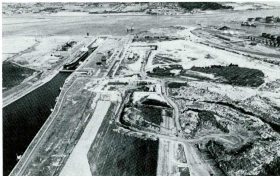
A gauche, l'actuelle écluse de Zandvliet. Au centre et à droite, les travaux d'excavation pour l'écluse de Berendrecht.
