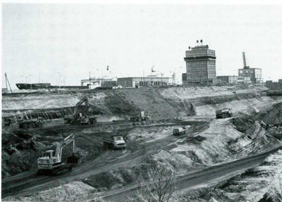
Uitgraven en eerste betonwerk Benedenhoofd, merk het bestaande controlegebouw op van de Zandvlietluis (uitvoerig beschreven in het Excavatornummer van augustus 1963).
