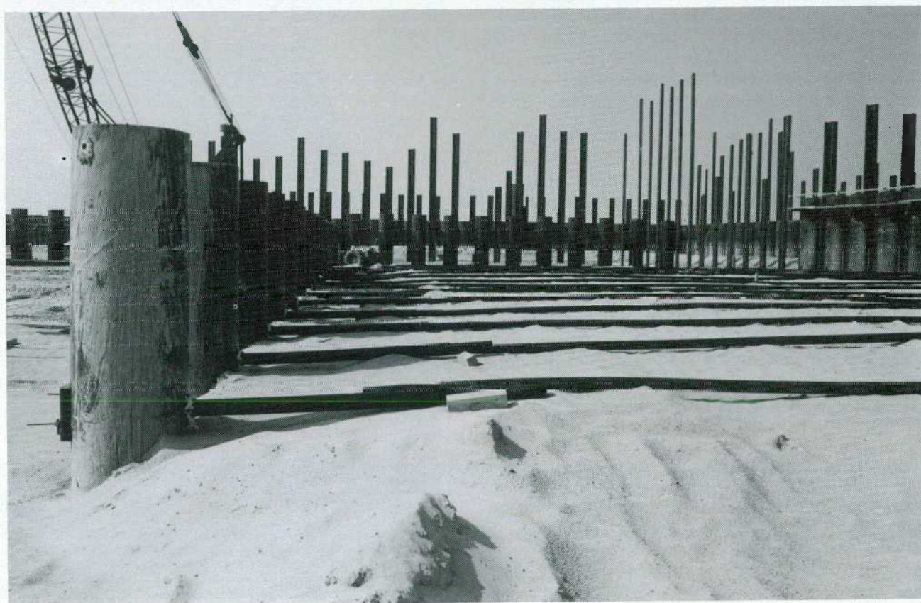
Foto 8. — Plaatsing ankers
