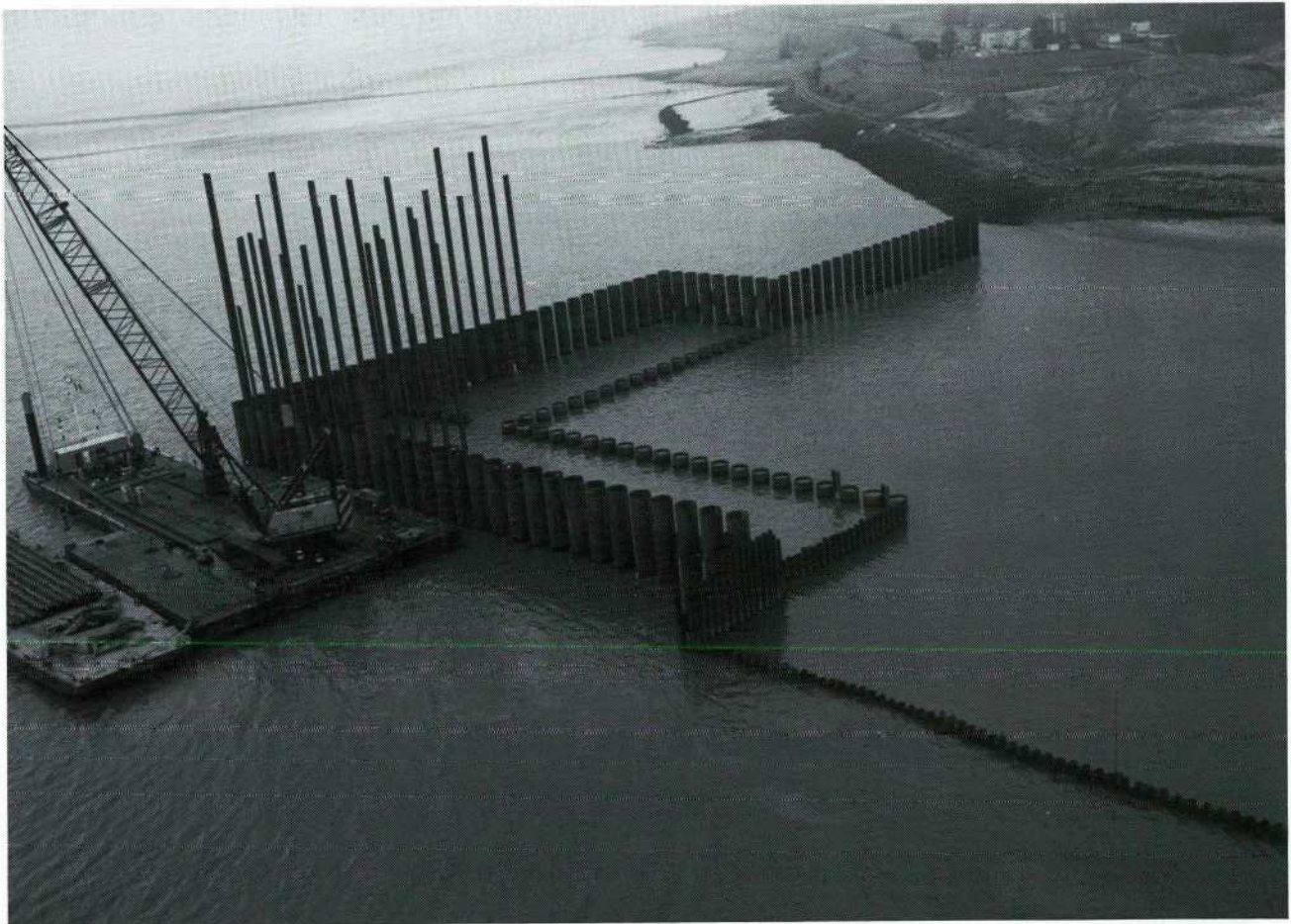
Foto 4. — Kaaimuur afwaarts uitgevoerd als een combiwand.
