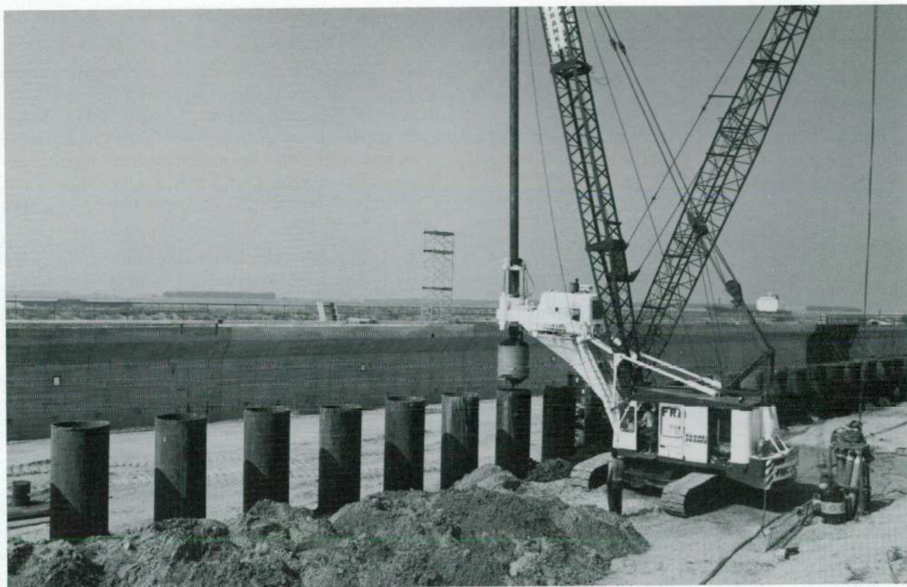
Foto 7. — Leegmaken ankerpalen met bucketschroef.
