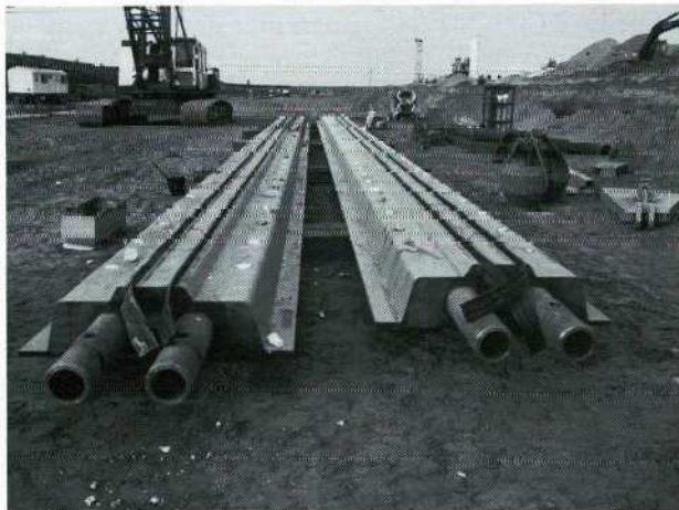
Foto 3. — Metalen voegprofiel voorzien met 2 thermoplastische strippen.
