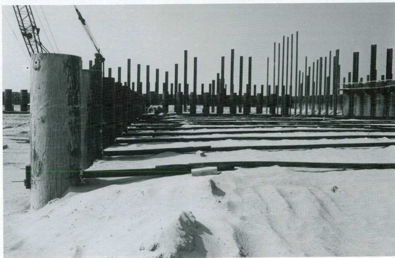
Foto 8. — Plaatsing ankers
