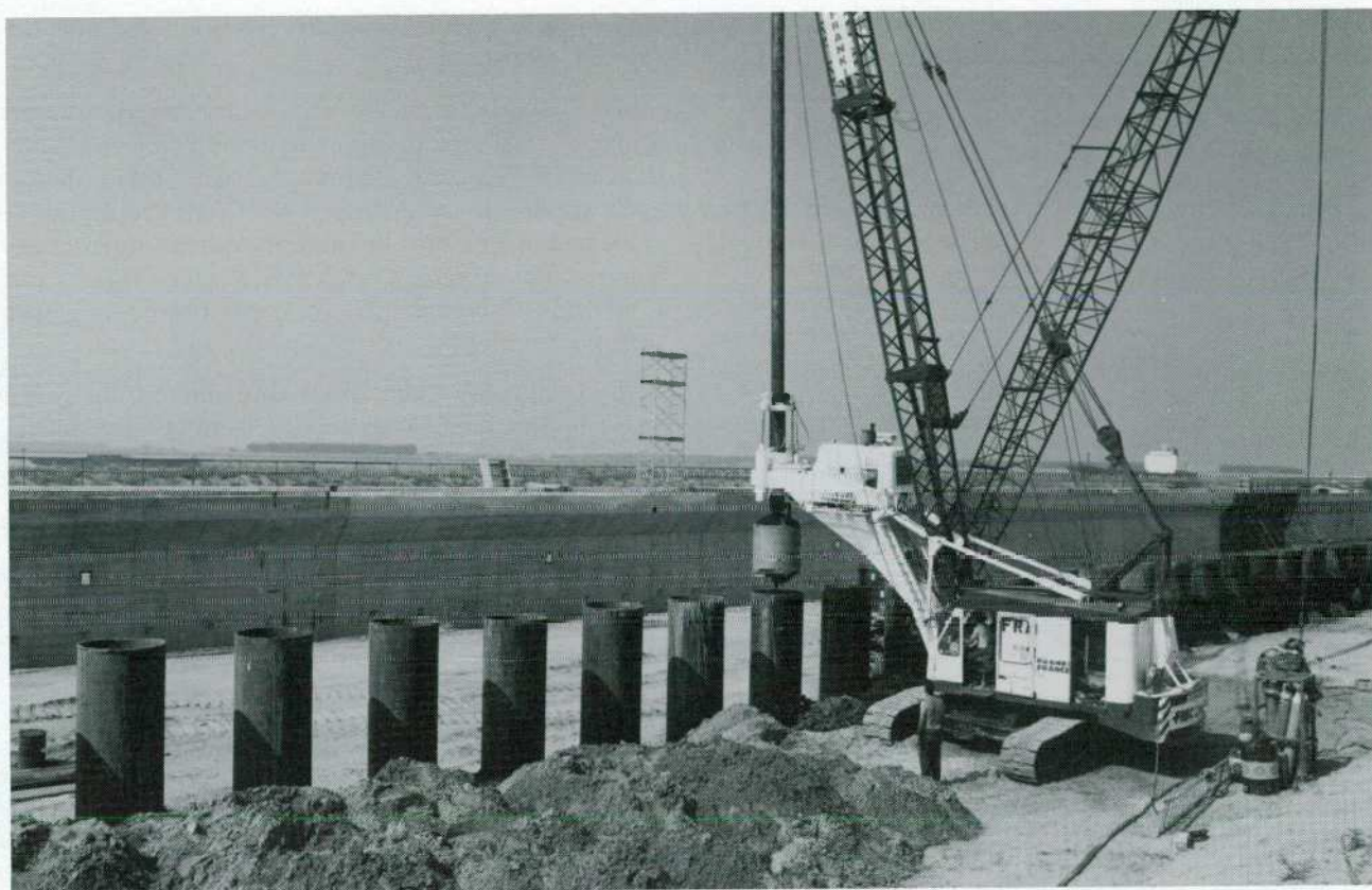
Foto 7. — Leegmaken ankerpalen met bucketschroef.
