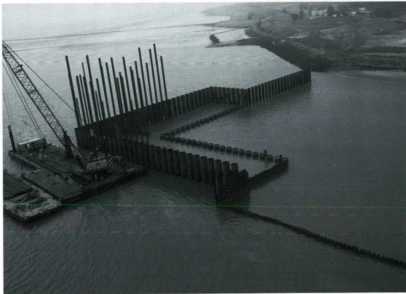
Foto 4. — Kaaimuur afwaarts uitgevoerd als een combiwand.
