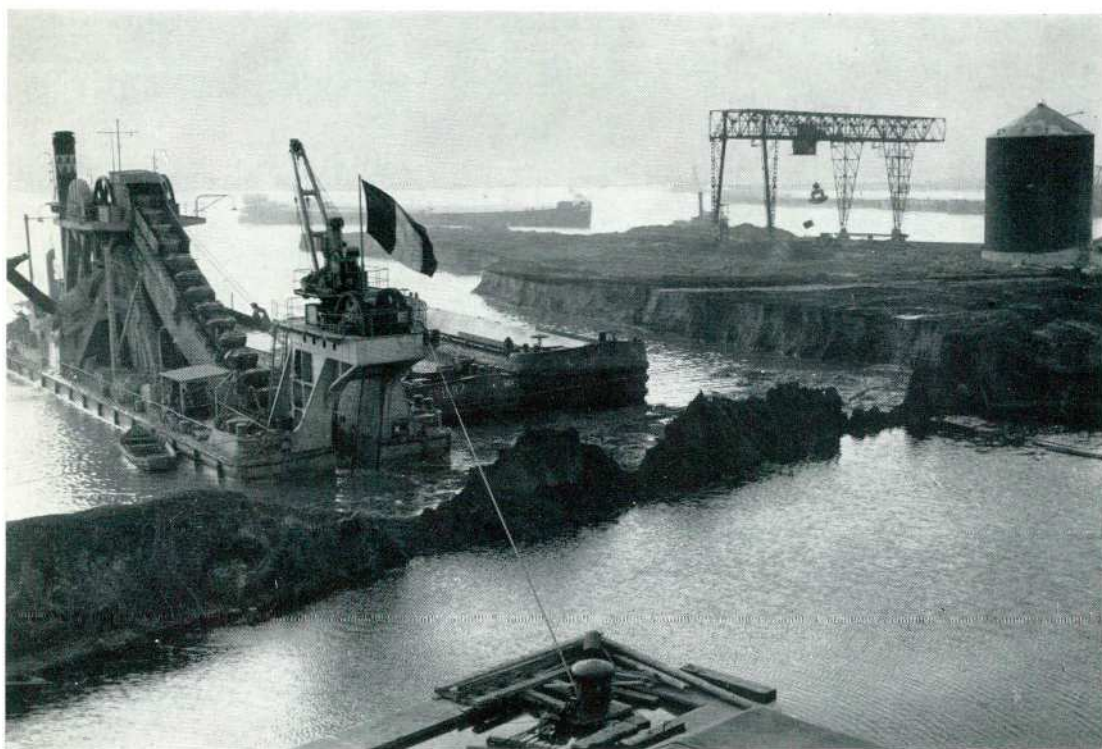
FIG. 42. — VUE VERS LE HANSADOCK. La drague va achever l'enlèvement de la digue entre le Hansadock et l'écluse.
