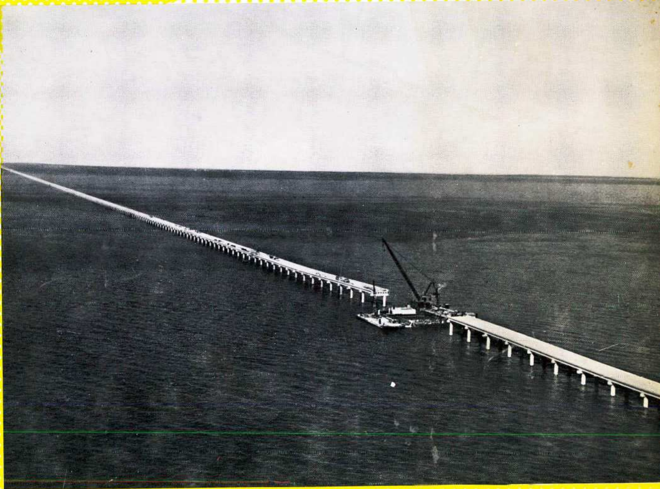
Le pont en béton précontraint de 38 km (2 232 travées de 17 m) sur le lac Pontchartrain (E.-U.)
