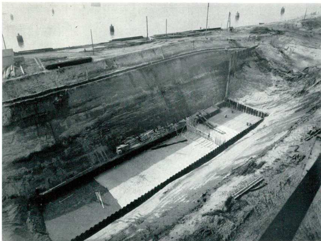
FIG. 32. — LA FOUILLE DES PRE- MIERS ÉLÉMENTS DU MUR SUD DU CHE- NAL D'ACCÈS (octo- bre 1953). L'Es- caut est au ni- veau + 6,00. La banquette, de 15 m de large seulement, entre l'Escaut et la fouille, est à + 7,50 environ. La fouille, dont le lulus est plus raide que 4/4, est au niveau -14,50, soit à 22 m au- dessous du niveau du terrain.
