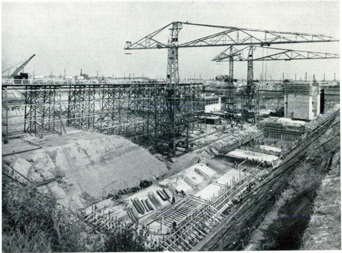
FIG. 30. — VUE GÉNÉRALE DE L'ENSEMBLE DU CHANTIER (juillet 1952).
