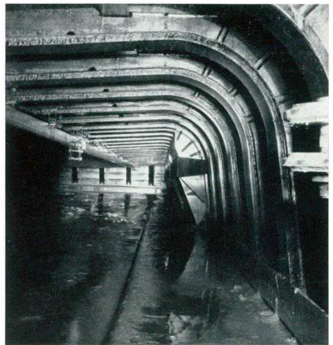
FIG. 16. — VUE INTÉRIEURE DU CAISSON DE MISE À SEC.
