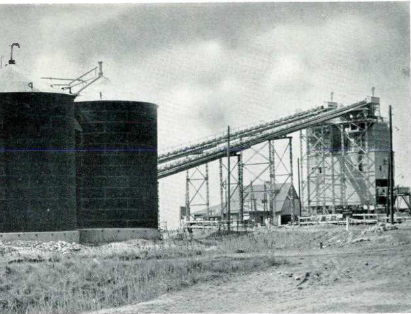
AGEMENT, STOCKAGE ET MANUTENTION DES MATÉRIELS; rangement; au centre, les deux silos, d'une ale de bétonnage alimentée par courroies
