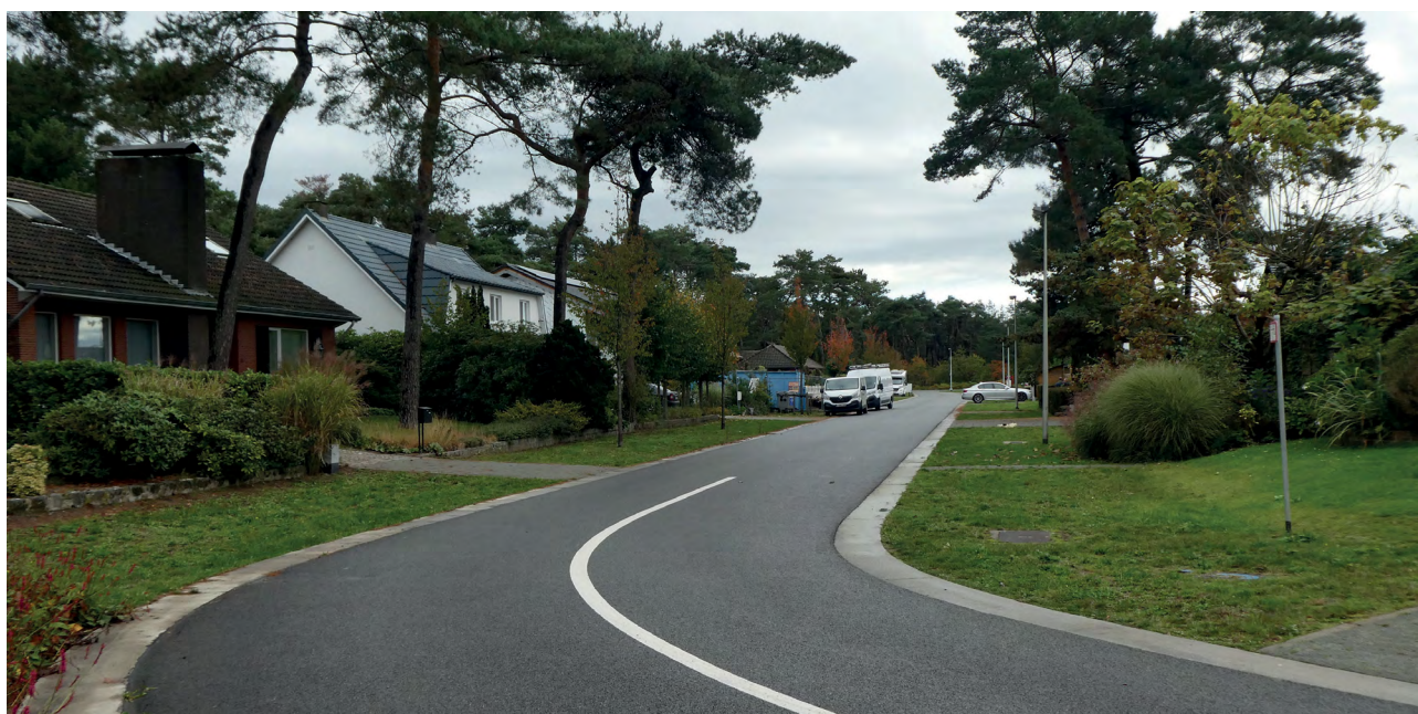
Door de stoepen te vervangen met groene bermen als wadi's werd een aanzienlijke oppervlakte in de Zavelstraat (Pelt) onthard. In de groene zone kan het water van de weg enis vlot infiltreren.
