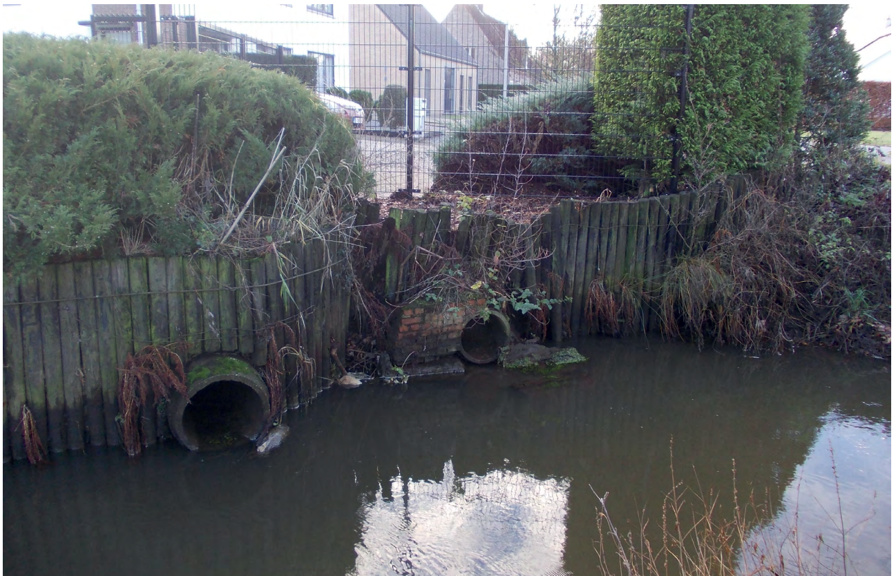
Uitlaat van overstort en RWA (regenweerafvoer) thv de Watermolenstraat in Pelt.
