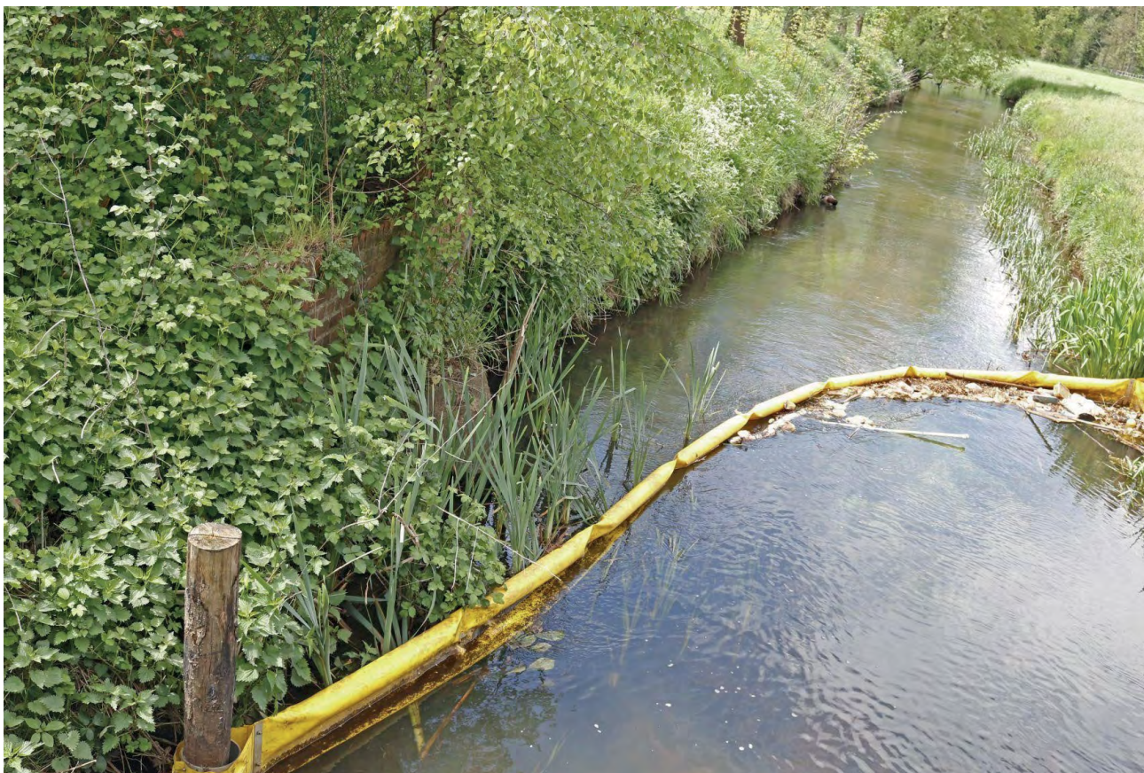
De zwerfvuilvanger op de Dommel houdt vooral blikjes, plastic en groenafval tegen.
