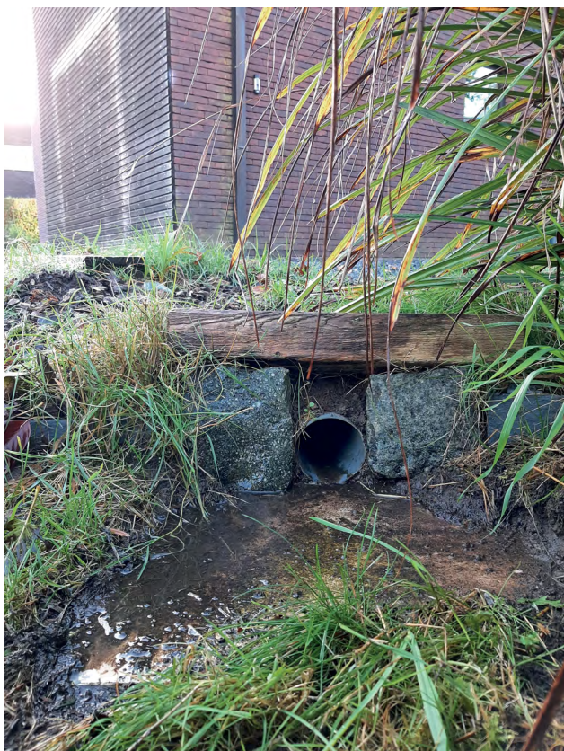
Voorbeeld van afkoppeling regenwater van het dakoppervlak met uitstroom in infiltratiekom en plantenborder.
