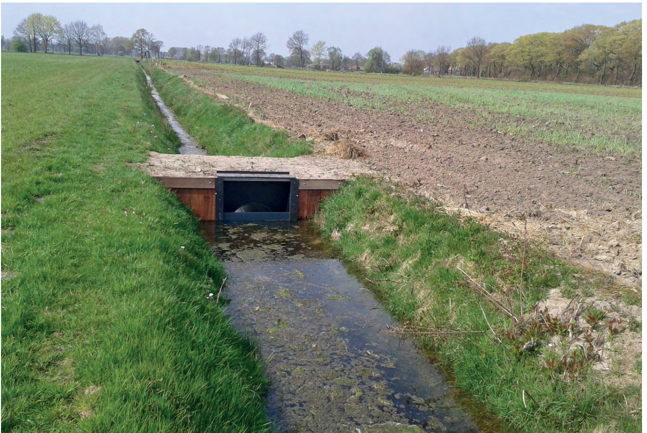
Een regelbaar stuwte op een perceelsgracht (Foto: Boerenatuur Vlaanderen).
