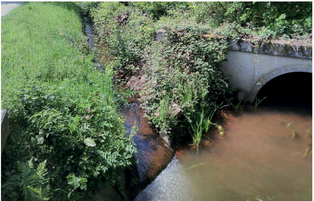
Het drainagewater van de N74 vloeit naar het waterloopstelsel.
