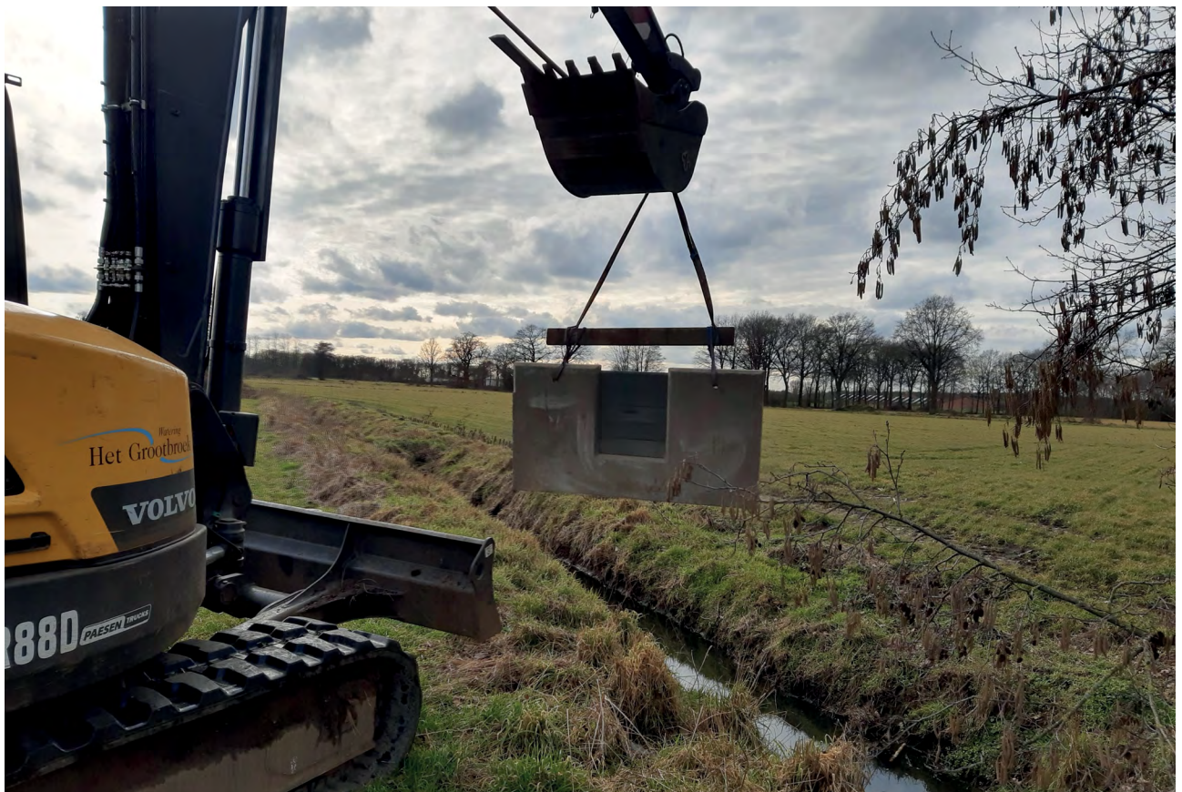
Een regelbaar stuwtje wordt in de perceelgracht geplaatst (Foto: watering Het Grootbroek).
