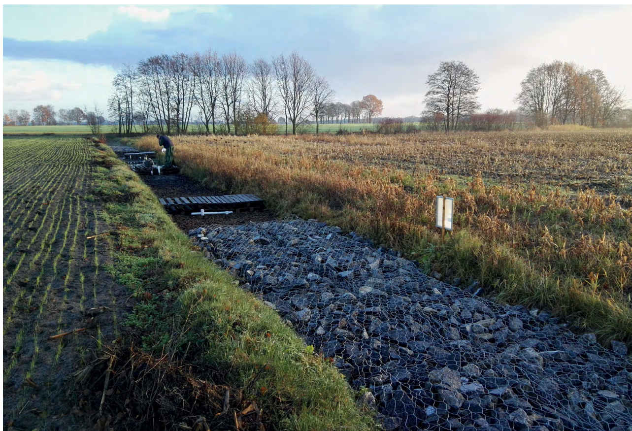
Aanleg van een bioreactor in een gracht naar de Bolissenbeek (Foto: Proefcentrum Fruitteelt vzw).
