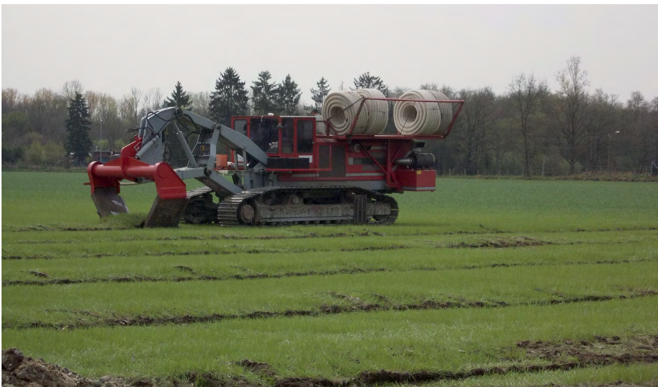
Machine legt drainagebuizen voor peilgestuurde drainage
