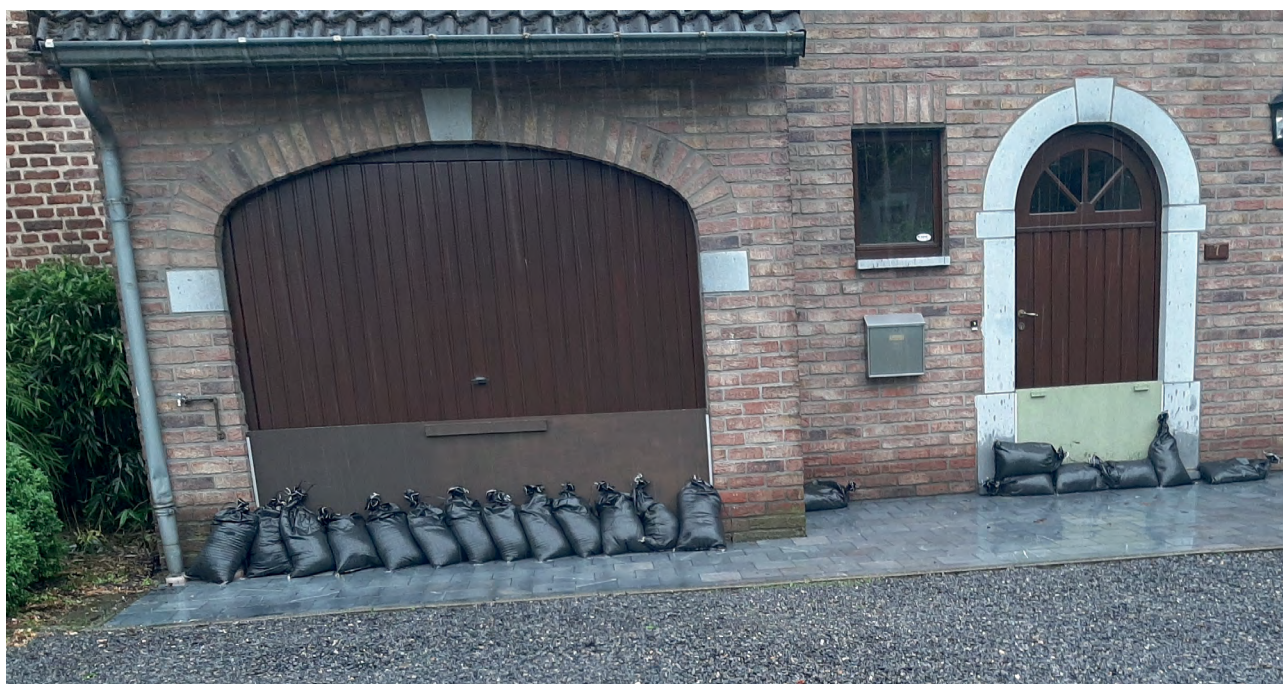
Voorbeeld van een individuele beschermingsmaatregel, waarbij schotten geplaatst zijn in de garage- en deuropening
