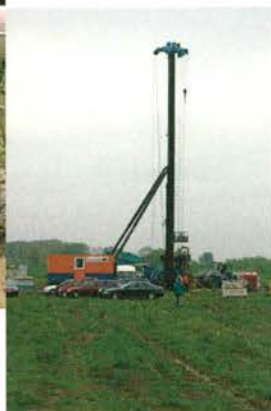
8.2 • Voorbeeld van een innovatieve techniek, een praktijkproef uiterwaardverlaging bij Everdingen met behulp van een zuiglans (foto's Gertjan Geerling).
