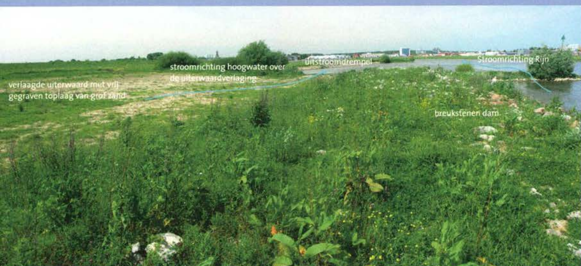
5.13 • Zicht op de uitstroom van de verlaagde uiterwaard in de Bakenhof. Rechts is de rivier zichtbaar en een breukstenen zomerkaai, links is het verlaagde deel zichtbaar
