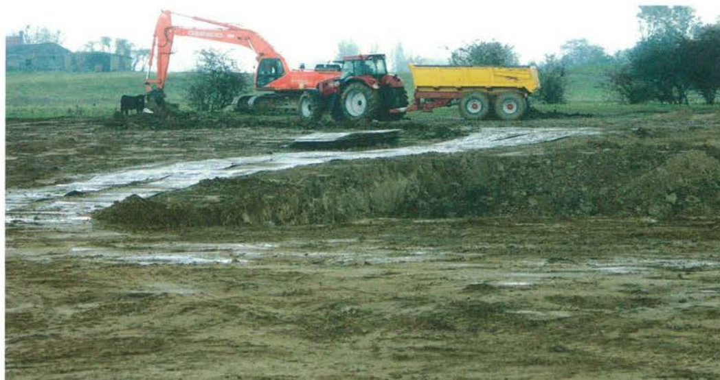
8.3 • Het afgraven van rooftergrond en klei in de Millingerwaard (foto Bart Peters).
