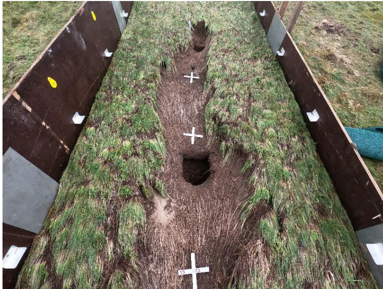
Bijlage Figuur B.1 Schades aan het einde van de proef
