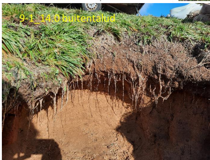
Figuur A-3 Bodemproefiel 9-1 14.0 binnentalud strook 2-2 en buitentalud strook 2-1 (boringen gestoken voorafgaand aan de erosieproef)
