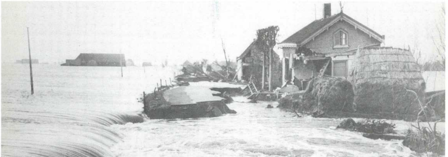
De stormvloedramp van 1953 heeft enorme, deels onherstelbare schade toegebracht.
