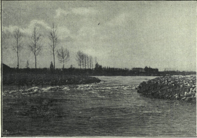
15. — Brèche du Grootbroek. — Construction du barrage.
