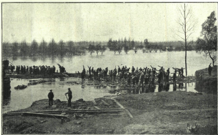
17. — Breche de Moerzeke — Construction du barrage
