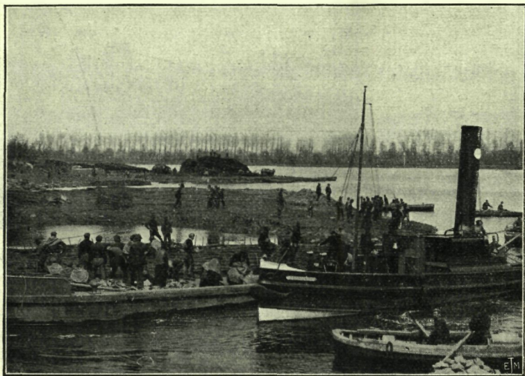
14. — Brèche de Moerzeke — Échouement d'une plate forme de fascinage.
