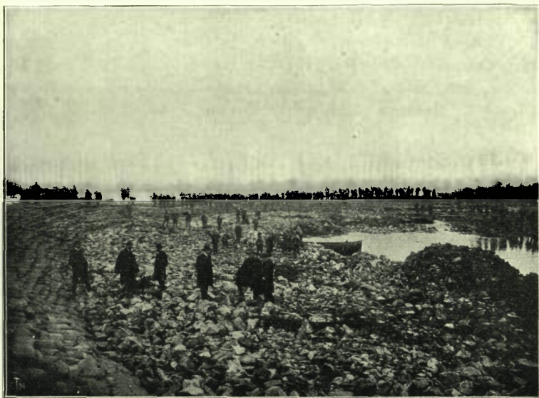
11. — Breche de Castel. — Moerzeke. — Construction du barrage.
