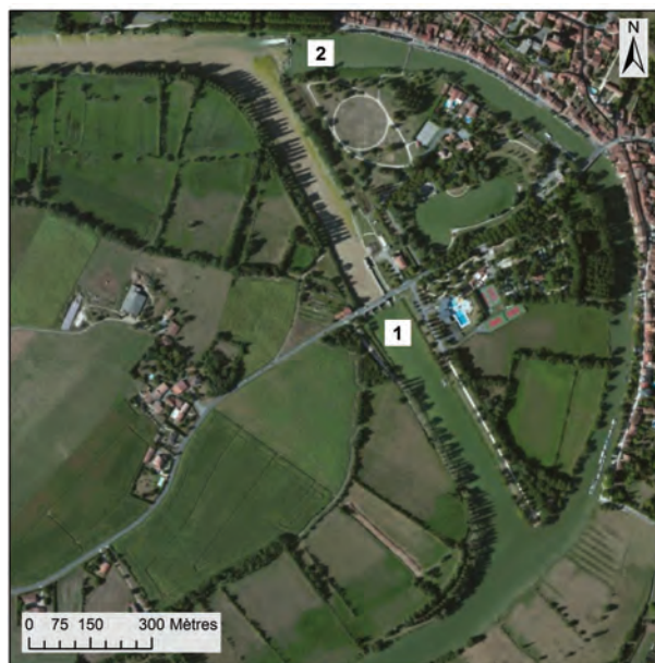
FIGURE 2.7 – La Charente à Saint-Savinien 1 : Bras artificiel, barrage 2 : Bras naturel, clapet
