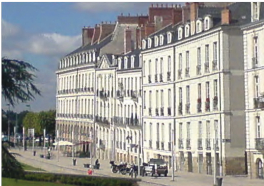
Figuur 1: Nantes aan de Loire: de huizen verzakken omdat de grondwaterstanden gedaald zijn door lagere waterstanden in de rivier.
