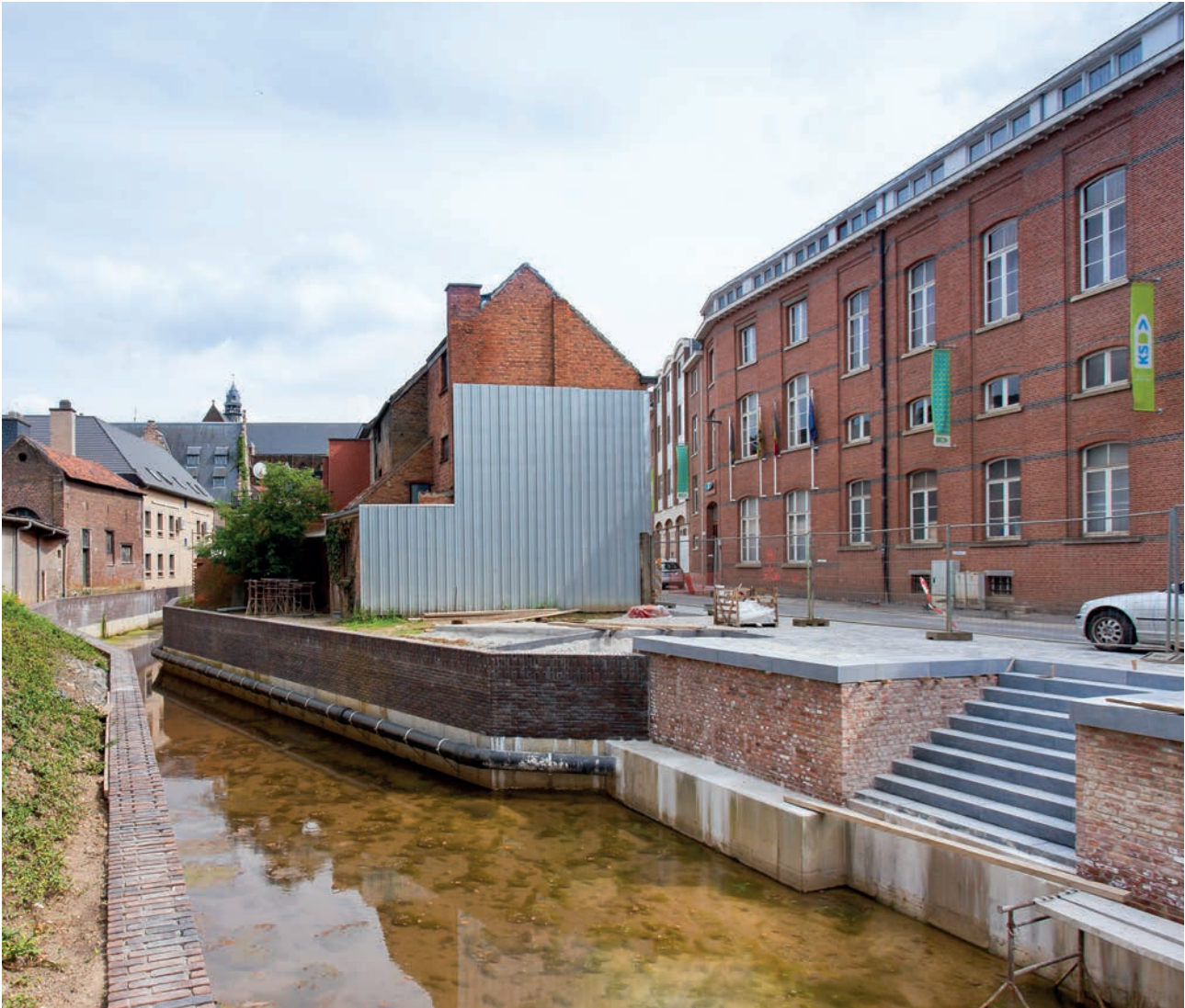
De historische toegangstrap in de Demerstraat werd gereconstrueerd.
