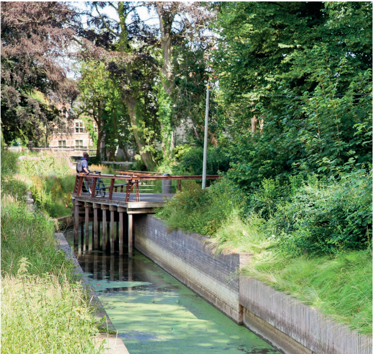
In de Schaffensestraat werd naast de Demer een vlonderpad met uitkijkplatform aangelegd.
