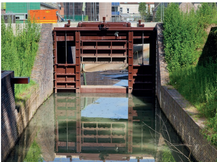
Een schuivenconstructie regelt het waterpeil in de nieuwe Demer.
