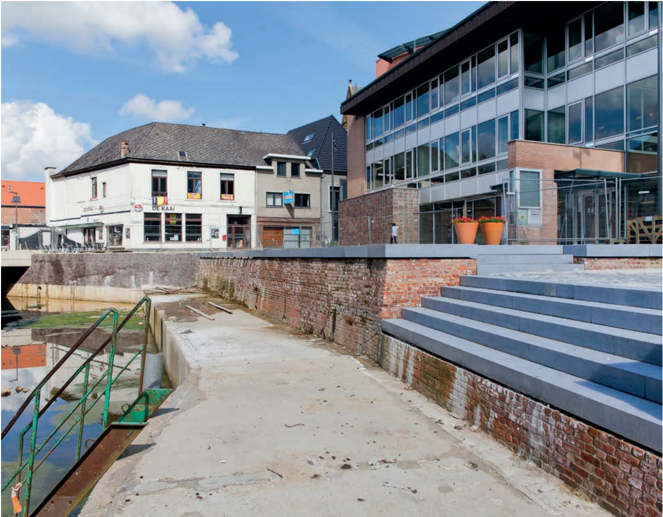
De historische kaaimuur en de trap werden gereconstrueerd. Het wandelterras onderaan wordt afgewerkt met houten planken.
