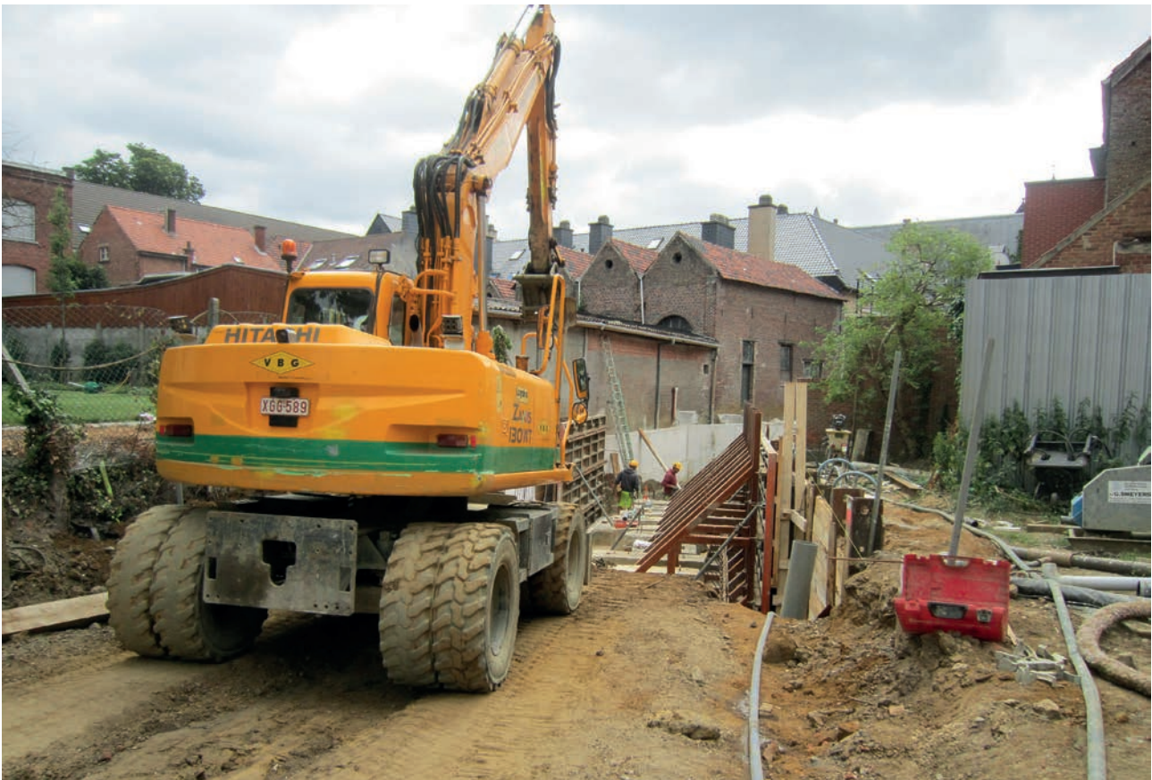
Waar vroeger de oude schipbrug lag, bouwde de VMM een nieuwe brug, afgewerkt met cortenstaal.
