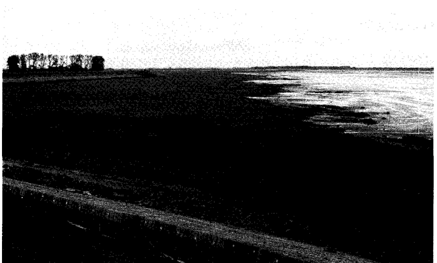
Westerschelde, Schor Zimmermanpolder, 6 juni 1999; ingrijpende werkzaamheden in het kader van Dijkbekleding Westerschelde ( Pim Wolf )
