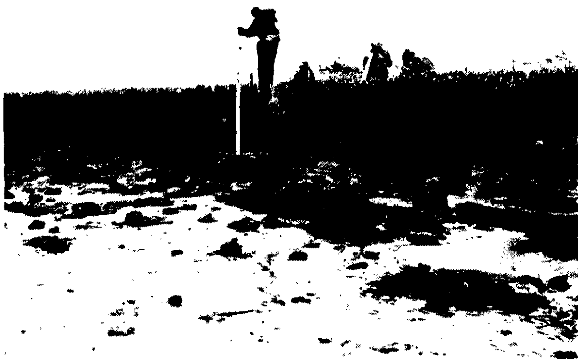
Foto 4. Het uitvoeren van een waterpassing, aan de 'Ijebreker' (kreek in het Verdrinken Land van Saeftinghe)
