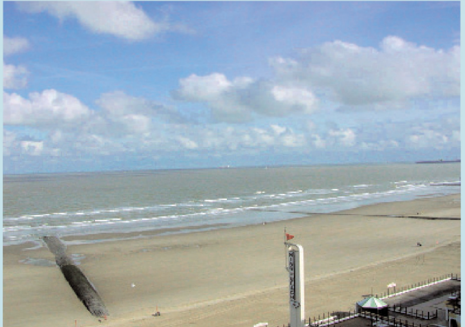
Strandhoofden zijn op vele plaatsen langs de Vlaamse kust aanwezig om strandaangroei te bevorderen en erosie tegen te gaan. Zij vormen een barrière voor het langstransport (VL)
