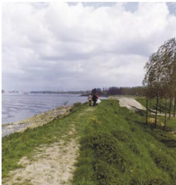
Sporen van kleine dijkbreuken in de zomerdijk vóór het Groot Schoor op 4 mei 1975.
