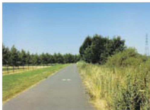
De verdubbeling van de transportcapaciteit van de hoogspanningsleiding, zichtbaar op de foto's van Charlier (1981) en van Kempnaers (2003).
