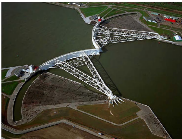
Figuur 10: Stormvloedkering van het type "nieuwe waterweg"
