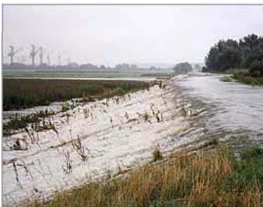
Figuur 6: Scheldewater stroomt over de overlooptdijk het GOG van Tielrode in
