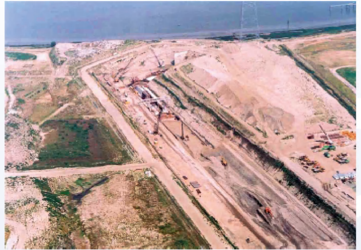
Werken aan het Deurganckdok in volle gang
