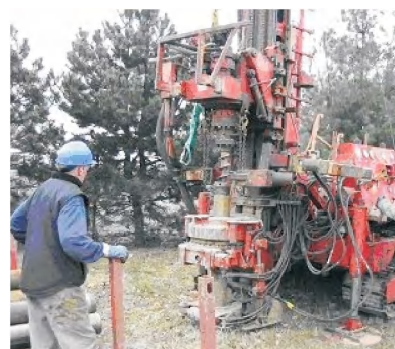
Boringen voor grtndwatermonitoring in het Maasbekken
