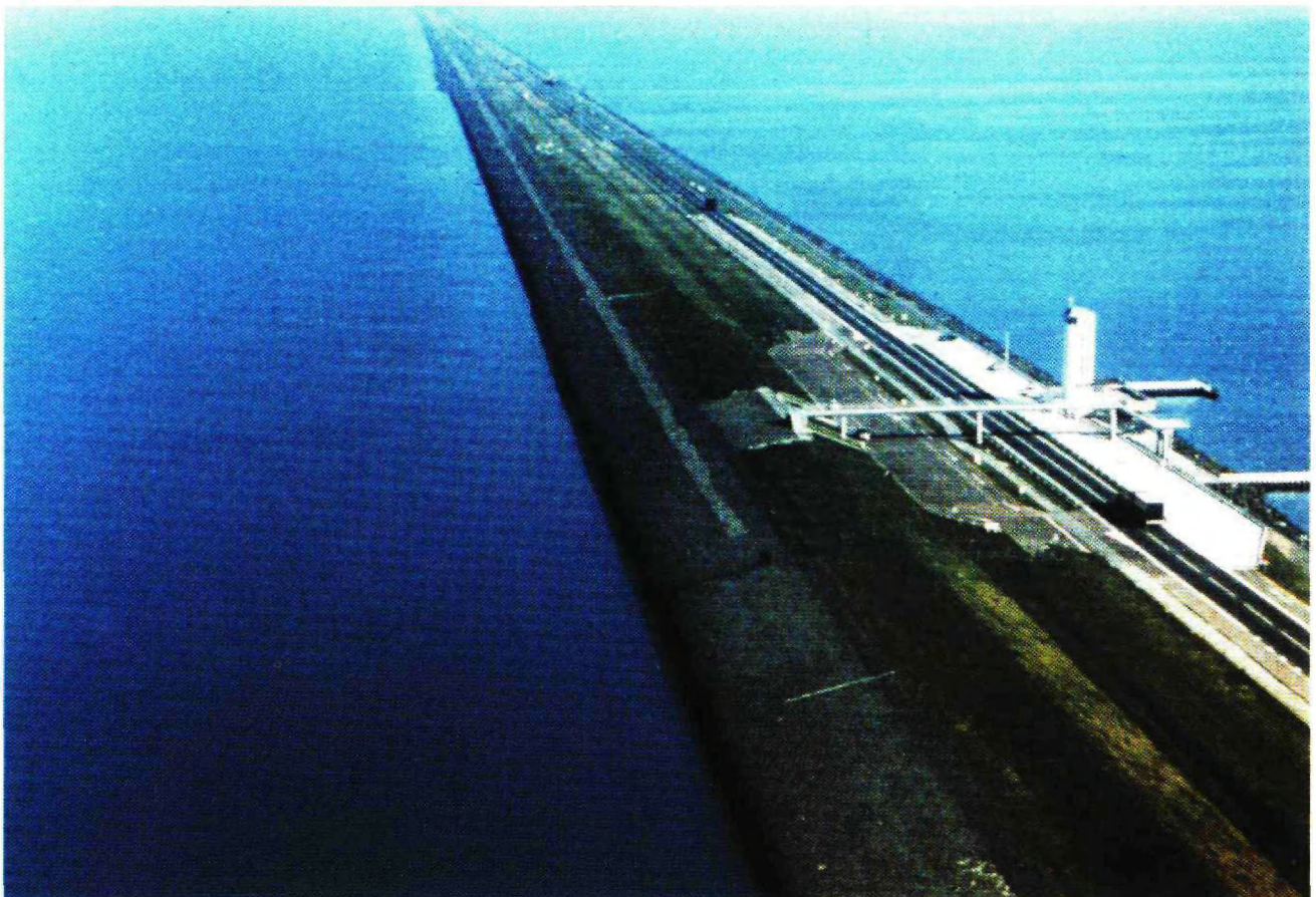
Dijken (zoals de Afsluitdijk) hebben in het kustgebied een harde scheiding aangebracht tussen zout en zoet water. Foto: Polyvisie-Hilversum
