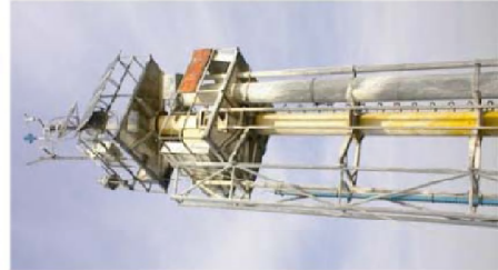
Meetpaal bij Brouwershavense gat 2
