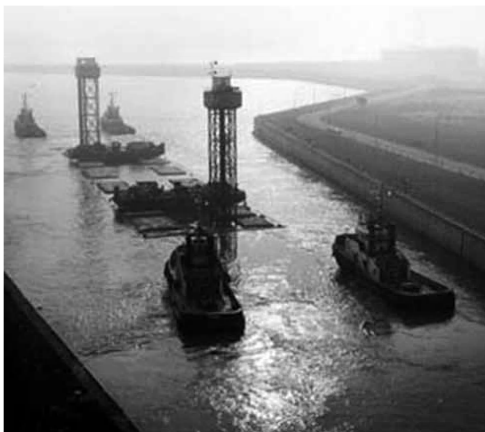
■ Tijdens de bouw van de Liefkenshoektunnel kreeg de Kallosluis in Antwerpen wel een heel aparte bezoeker. De tunnelelementen van de Liefkenshoektunnel, die in een droogdok (het huidige Vrasenedok) waren gebouwd, werden via de Schelde naar hun definitieve plaats gesleept en afgezonken (bron: www.liefkenshoektunnel.be )
