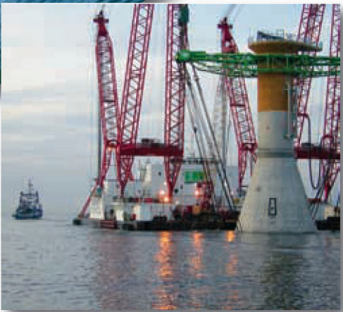
Transport windmolensokkel naar de Thorntonbank © C-Power
