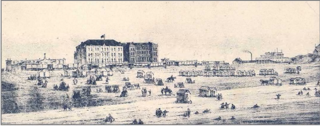
8 - Hotel de l'Océan en Pavillon du Rhin (SAO PK/B0801)
