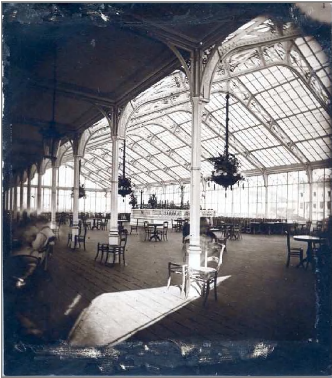
6 - Binnenzicht van de glazen zaal van het eerste kursaal op de dijk (SAO FT/B0744)
