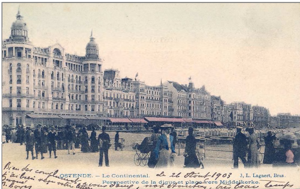
14 - Hotel Continental (links) en de overige hotels op de dijk (SAO PK/B2103)
