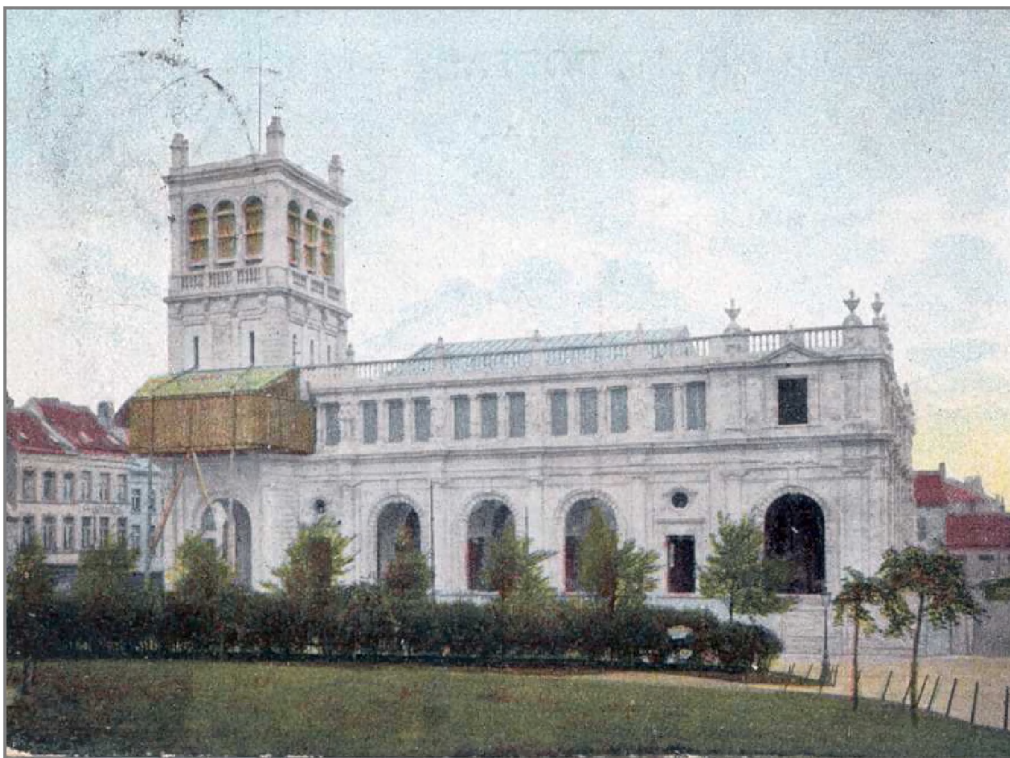
58 - Het nieuwe postgebouw in aanbouw (SAO PK/B0183)
