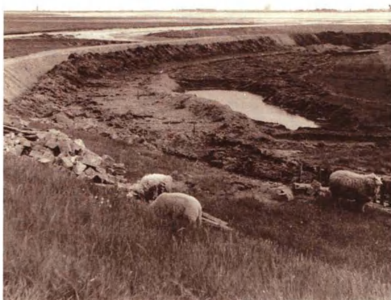
Aanleg Brielsche Maasdam, najaar 1949, fotograaf onbekend
