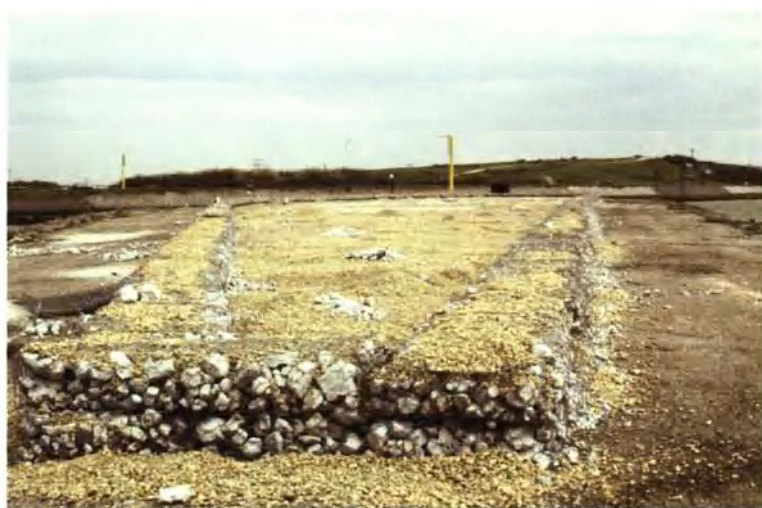
Splitsingsdam (Nieuwe Waterweg), 25 april 2000. Inrichting van broedplaats voor kustbroedvogels met schanskorven, schelpen en grind, Floor A. Arts
