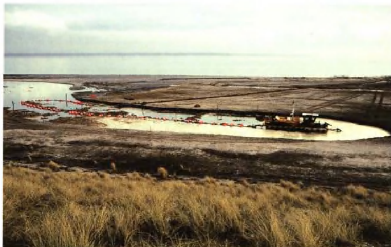
Cutterzuiger "Suzanna" aan het werk, Kleine Slufter 1 e fase, februari 1993, Norman D. van Swelm
