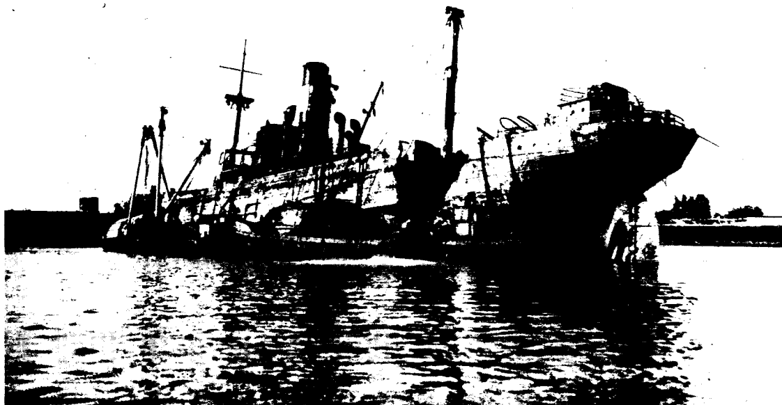
Hetzelfde schip nu na de berging. Duidelijk is het aanvaringsgat te zien.
