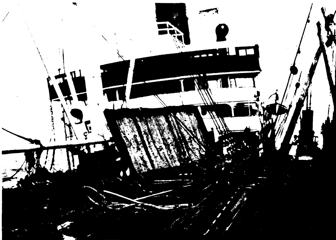
Het plaatsen van een zogenaamde "patch" bij de berging van de Yalou in 1928.
