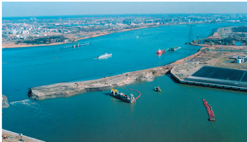
● Voor de aanleg van het getijdendok Deurganckdok wordt gebruik gemaakt van baggerschepen zoals een stationaire cutterzuiger. Dit tuig heeft een heel grote zuigkracht en is geschikt om de bodem weg te snijden en via drijvende leidingen aan land te brengen. DN
