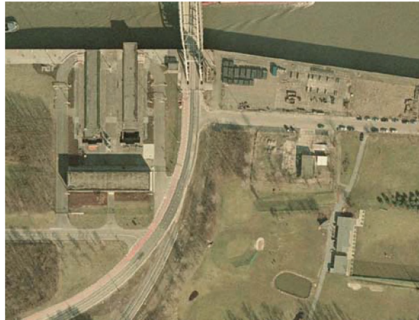
Figuur 50. Orthofoto van het sluisgebouw ter hoogte van het Kallosluis.
