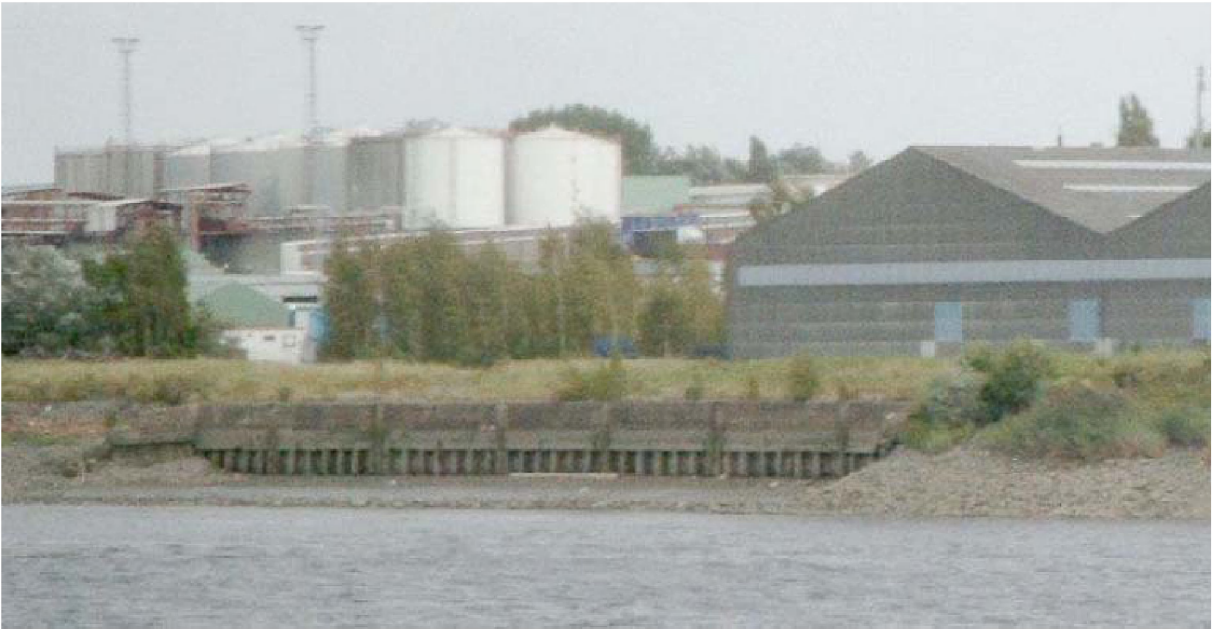
Figuur 41. Foto van een kaaimuur met ervoor een lichte helling.
