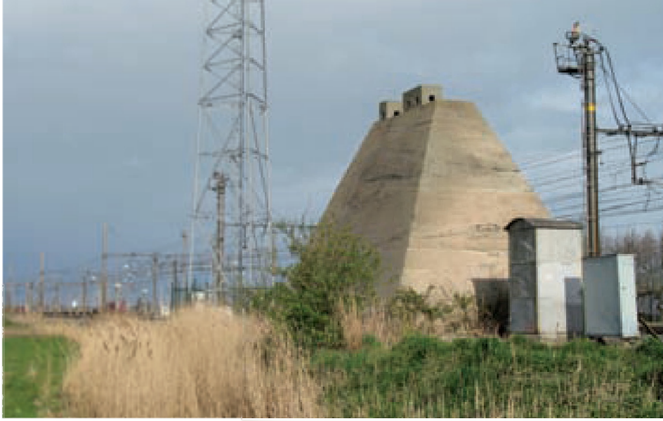
■ De Duitse personenschuilm bunker in Zandvoorde is nog steeds een merkwaardige verschijning naast de spoorlijn Brugge-Oostende. Het spitse dak was bedoeld om de bommen te doen afketsen (MR)
