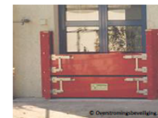
Schotten van gestapelde elementen in geleiderails
