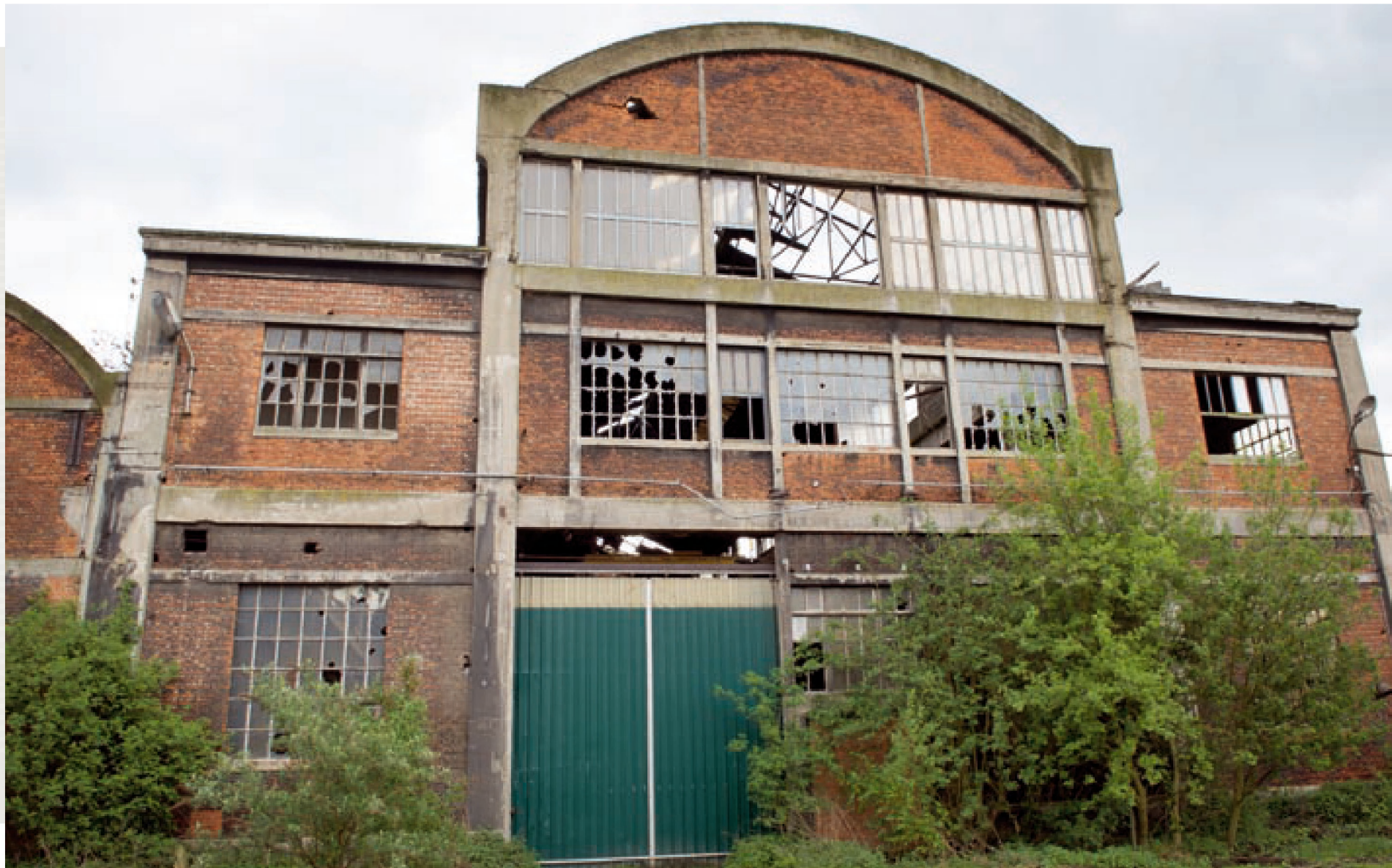
Oud gebouw op het bedrijventerrein Willebroek-Noord
