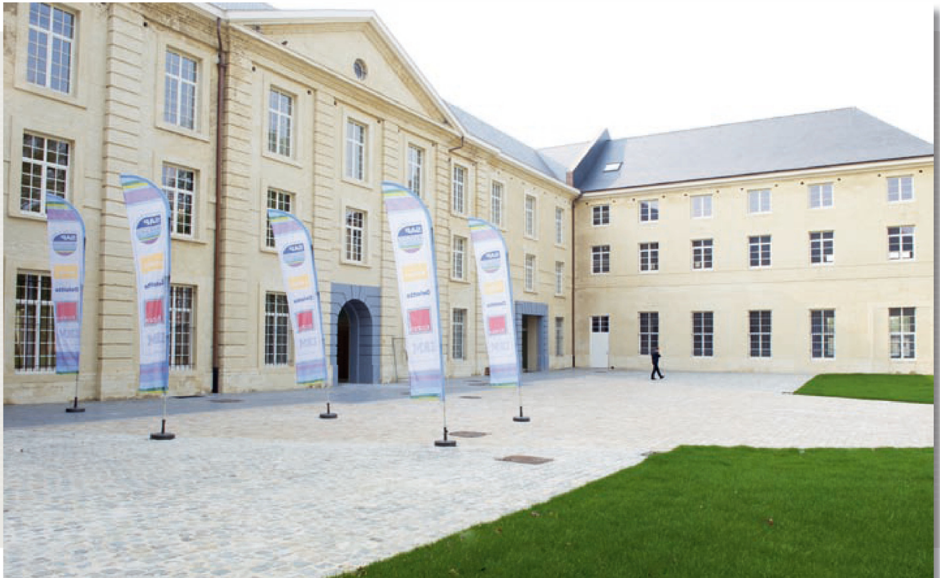
Gerestoreerd Tuchthuis als onderdeel van het project Vilvoorde Watersite aan het Zeekanaal Brussel-Schelde te Vilvoorde
