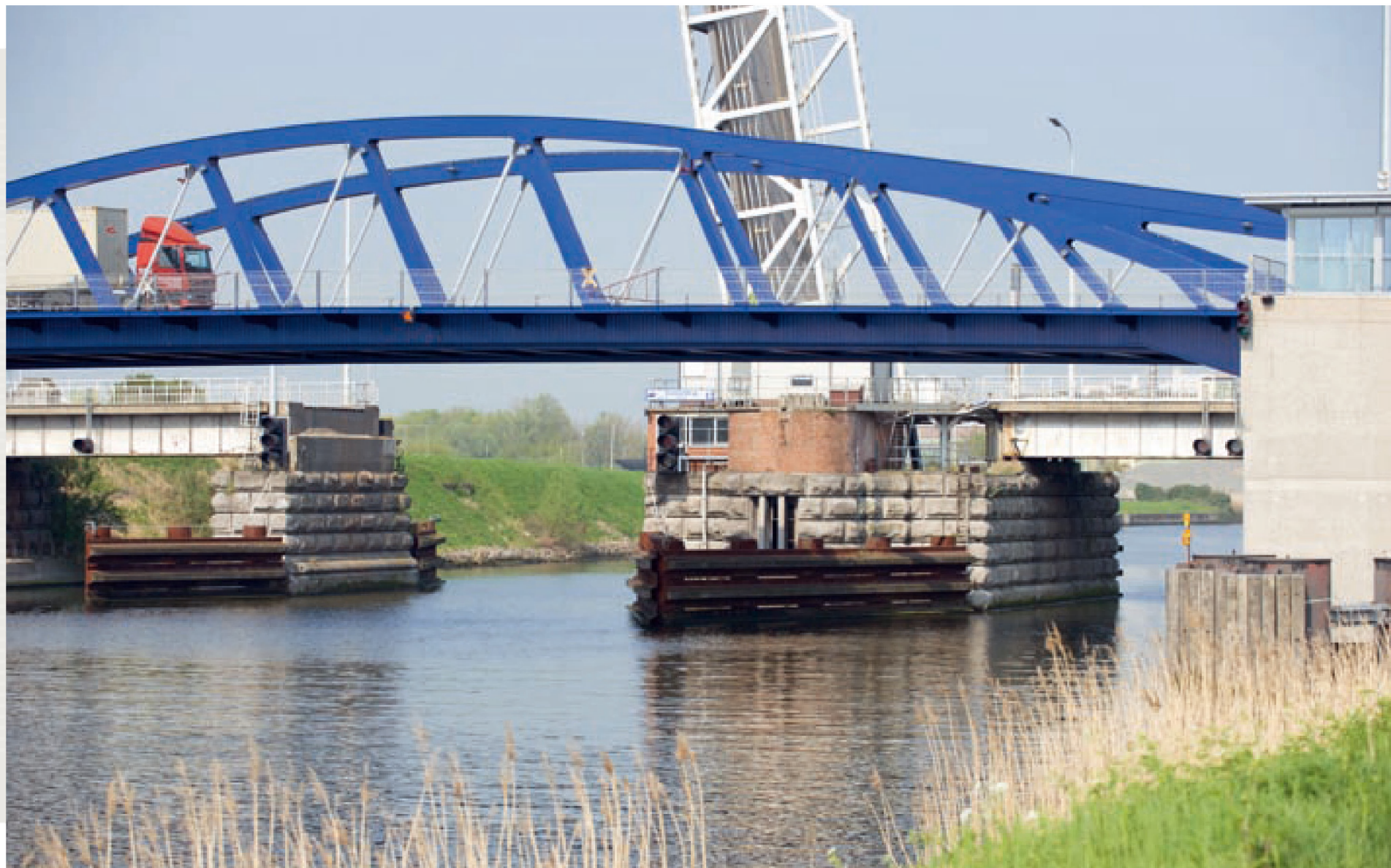
Nieuwe Boulevardbrug te Willebroek (Zeekanaal Brussel-Schelde)
