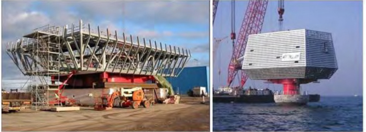
Figuur VIII-9: Constructie en installatie van een offshore transformatorstation [56]
