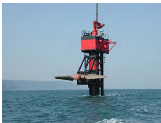
Figuur 5: MCT rotor in de onderhoudsstand, foto voor de kust van Schotland (Marine Current Turbines Ltd.)
