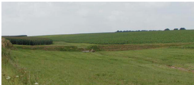
Foto 3 : Damconstructie in de Heulen Gracht.
