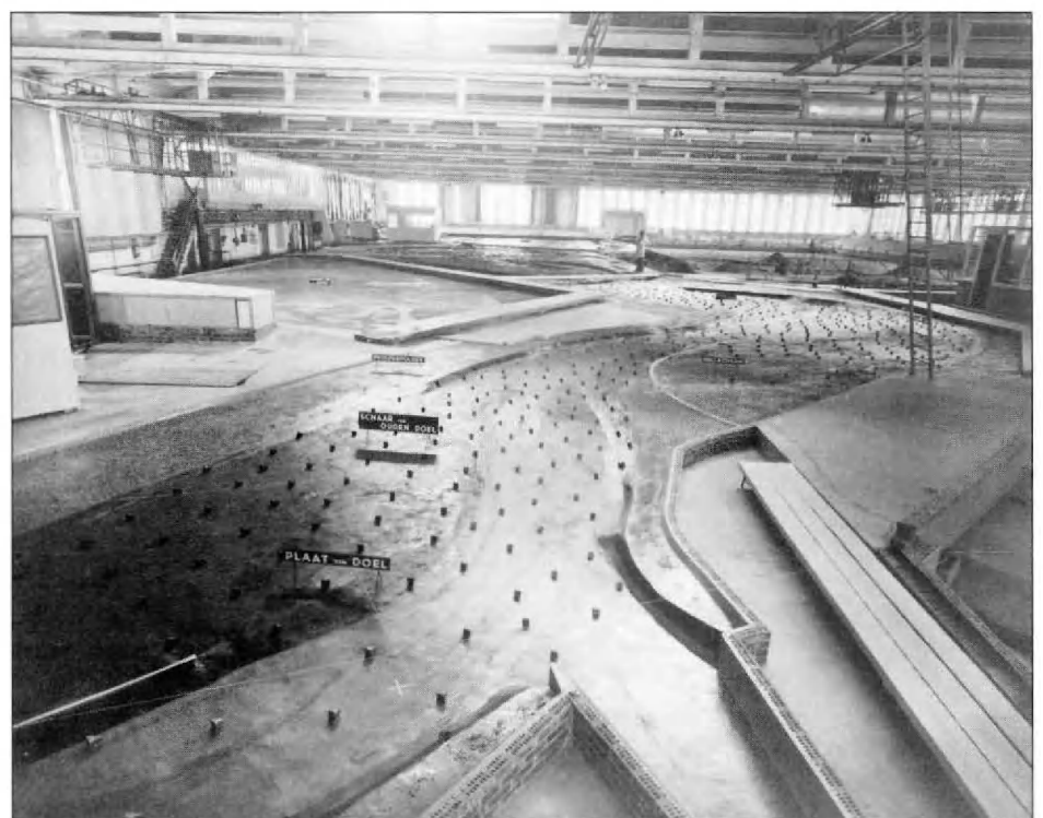
Figuur 14: Getijmodel Westerschelde Waterbouwkundig Laboratorium - Zicht vanaf Zandvliet naar afwaarts.
