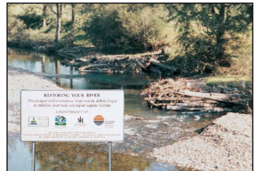
3 Foto's. Voorbeelden van 'natuurlijke' herstelprojecten in Australië, Engeland en Nederland (Geul), waar bij dood hout of omgevallen bomen in de waterloop (spontaan of aangebracht) zorgen voor een herstel van natuurlijke processen en habitats.
