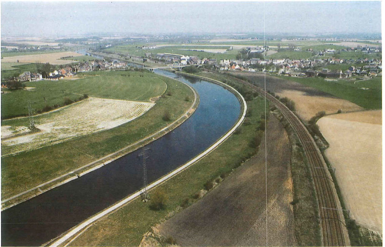
Fig. 143. Canal de Bruxelles à Charleroi, 1.350 t. Gouy-lez-Piéton. Sortie de la tranchée de la Fléchère côté Charleroi.
