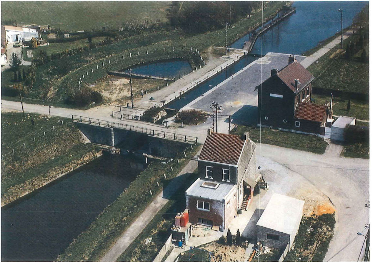
Fig. 80. Ecluse 13 avec vestiges d'un des deux bassins d'épargne (photo 1983).
