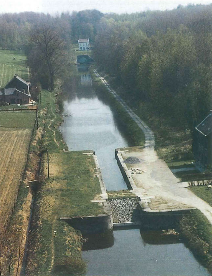
Fig. 79. Vestiges de l'écluse 12 à 300 t. C'était la première du versant Senne (photo 1983).
