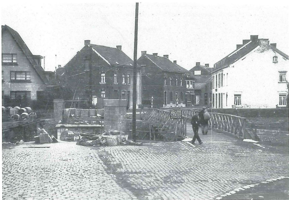
Fig. 136. Gouy-lez-Piéton. Construction d'un pont provisoire. 1940.
