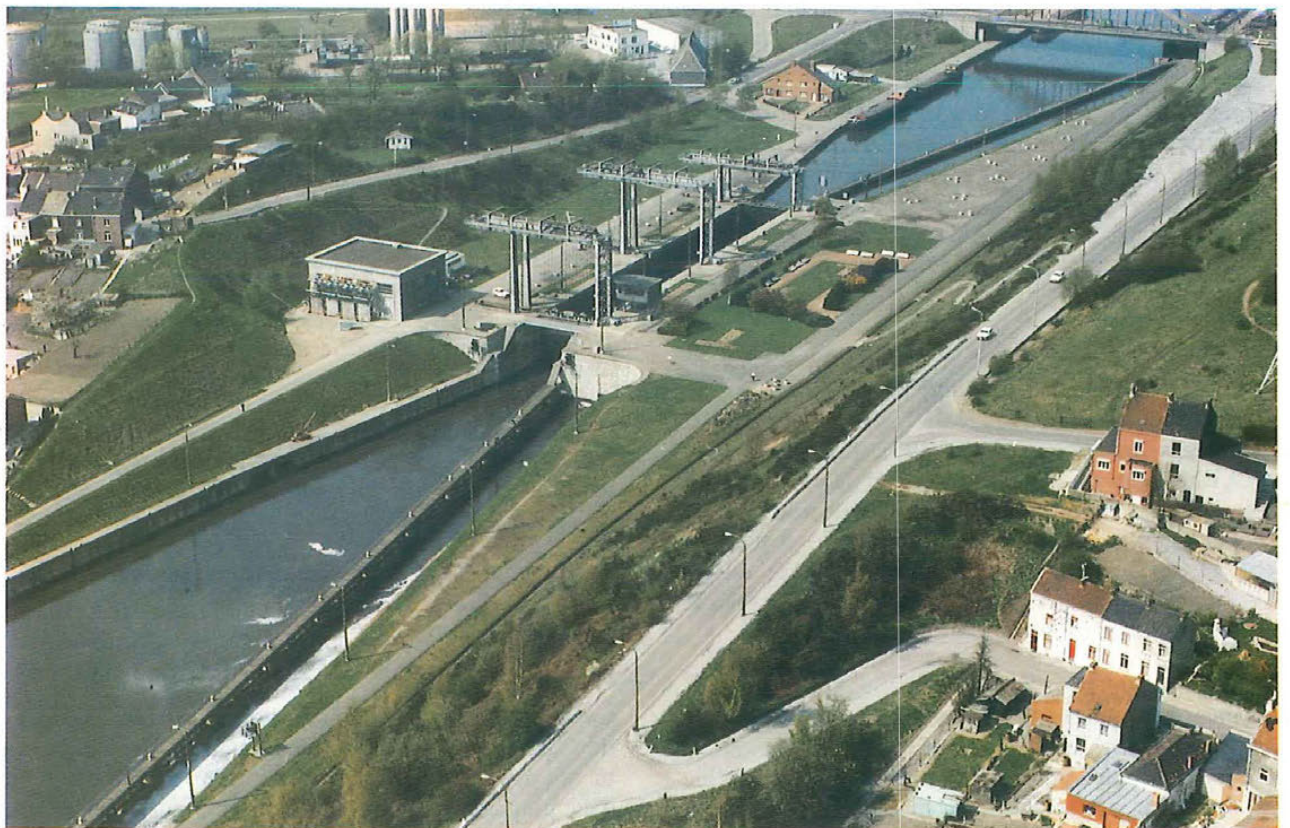
Fig. 140. Canal de Bruxelles à Charleroi. Ecluse n° 2, 1.350 t, Gosselies.
