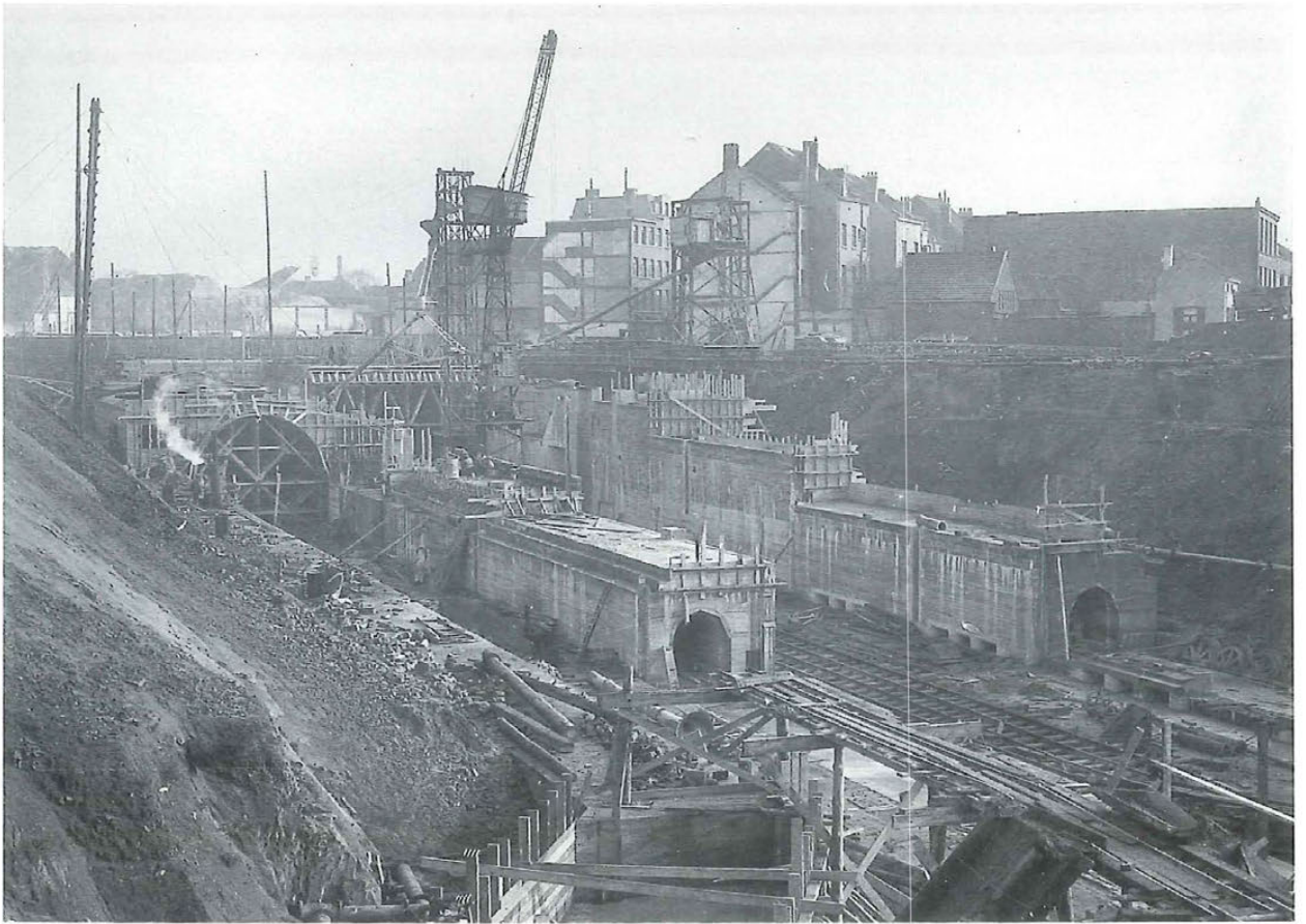
Fig. 117. Molenbeek. Construction de l'écluse.
