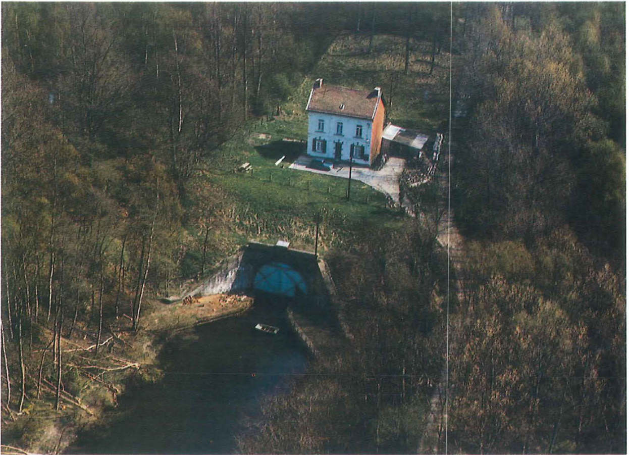
Fig. 78. Entrée du souterrain à 300 t - côté Senneffe.
