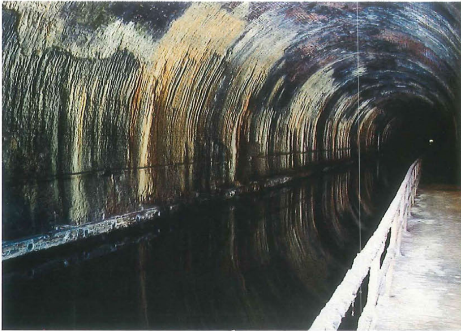
Fig. 81. Vue intérieure du souterrain à 300 t.
