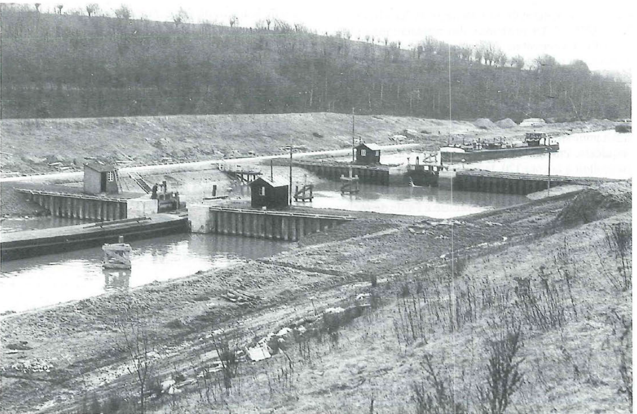
Fig. 146. Gouy-lez-Piéton. L'écluse provisoire sur le canal à 1.350 t. 1959.
