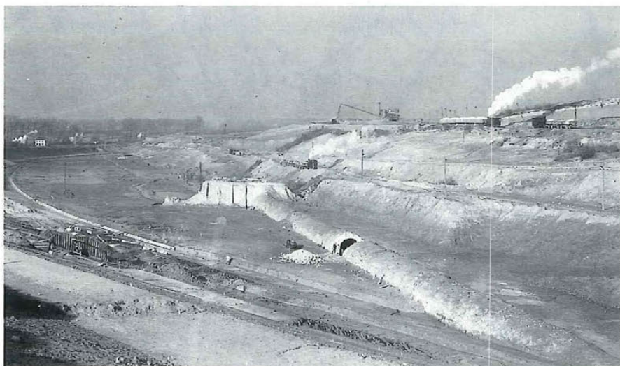
Fig. 43. Seneffe. Mise à jour d'une partie du souterrain de Bête Refaite lors du creusement de la tranchée du canal pour sa mise au gabarit de 1.350 t.
