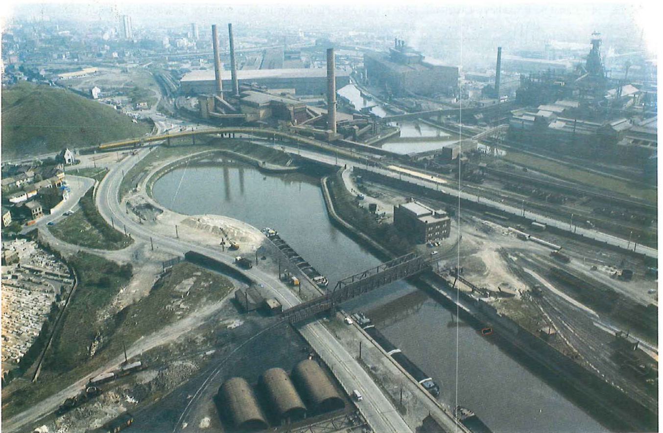
Fig. 142. Canal de Bruxelles à Charleroi, 1.350 t, le port à Dampremy.
