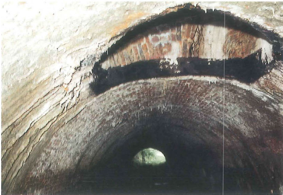
Fig. 37. Débouché d'un puits central en cheminée dans la voûte du souterrain.
