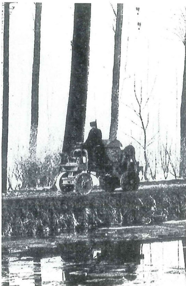
Fig. 127. Clabecq. Halage électrique sur berge.
