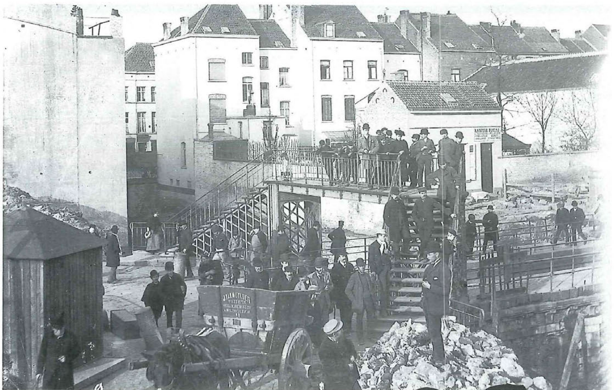
Fig. 100. Bruxelles. Passerelle franchissant le canal à 70 t (photo 1893).
