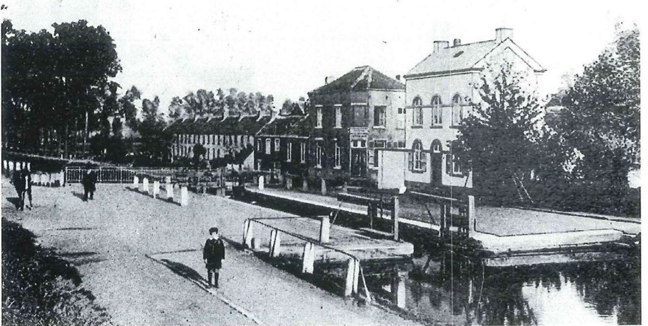
Fig. 67. Canal de Bruxelles à Charleroi à Buizingen.
