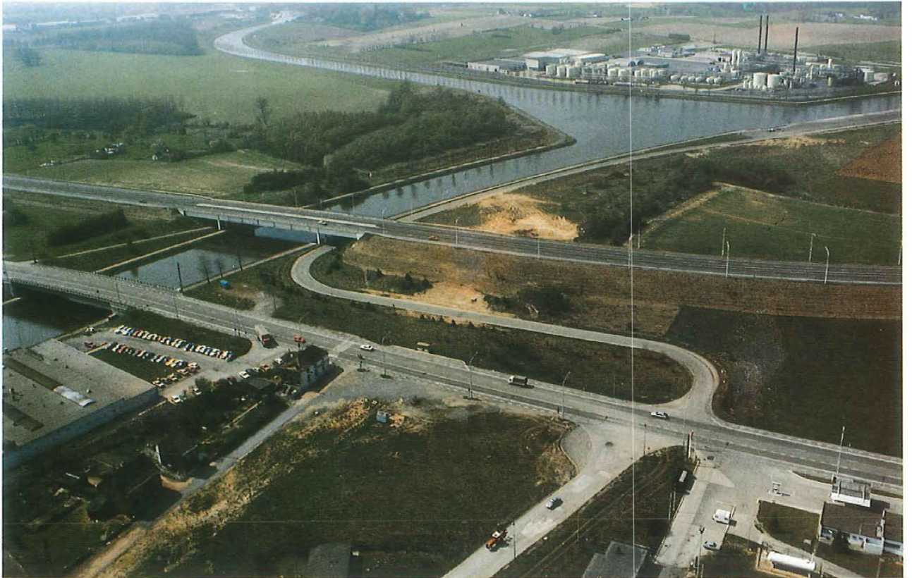
Fig. 149. Canal de Bruxelles à Charleroi, 1.350 t. Seneffe. L'embranchement vers La Louvière.
