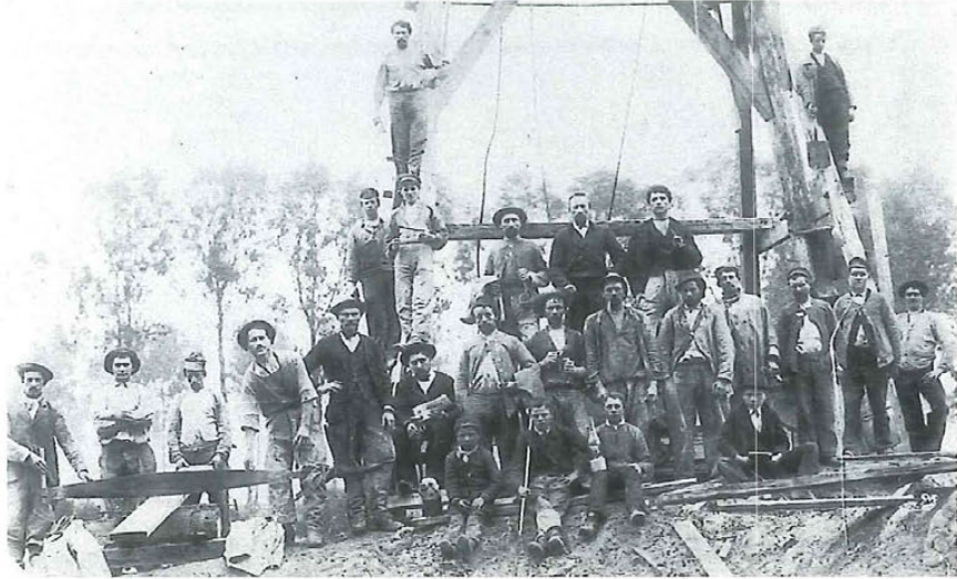
Fig. 92. La charpente en bois surplombant un puits de construction, et les ouvriers affectés à ce travail.
