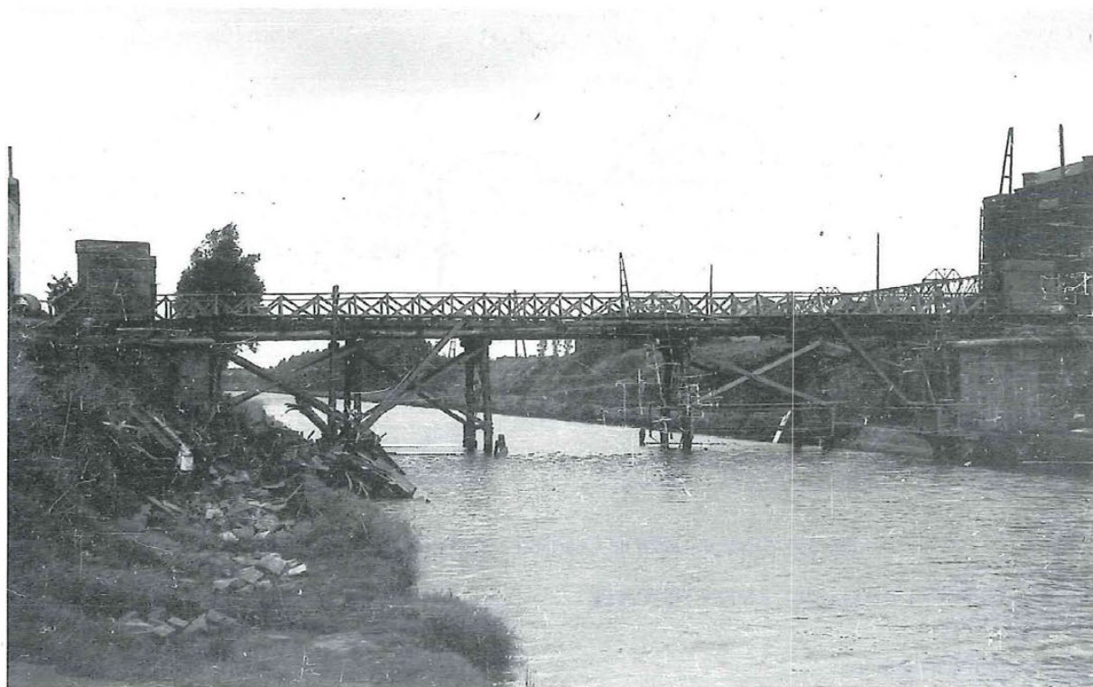
Fig. 137. Gouy-lez-Piéton. Construction d'un pont provisoire. 1940.
