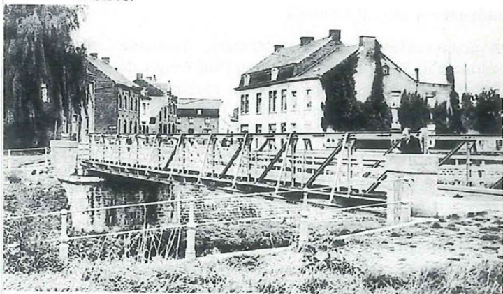
Fig. 123. Gouy-lez-Piéton. Le pont de la station.
