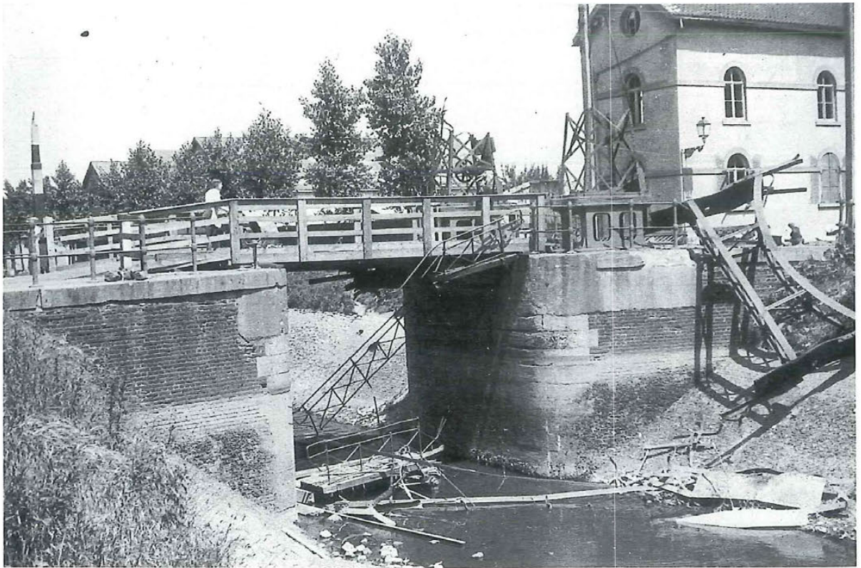
Fig. 135. Luttre. Destruction de l'écluse n° 10 en 1940.
