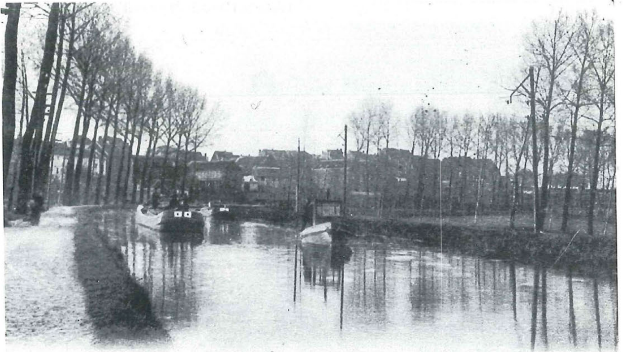
Hal. — Traction électrique sur le canal.
