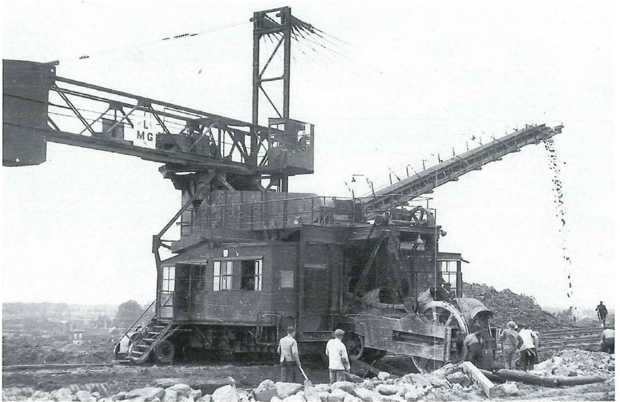
Fig. 148. Seneffe. Creusement de la grande tranchée. 1951.
