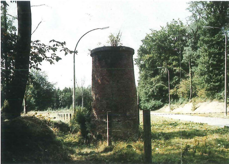
Fig. 82. Cheminée de construction du souterrain à 300 t.
