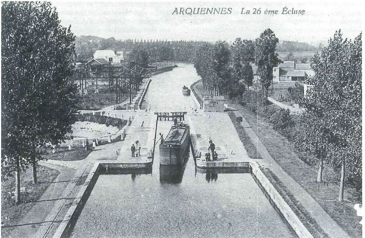
Fig. 23. Un sabot construit pour naviguer dans le canal à 70 t sort d'une écluse nouvellement aménagée pour bateaux de 300 t.
