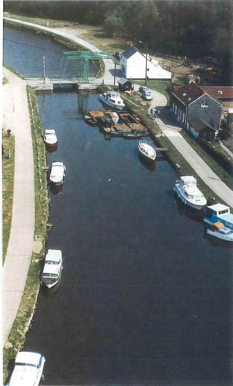
Fig. 104. Senefte. Le canal de jonction entre le 300 t et le 1.350 t.
