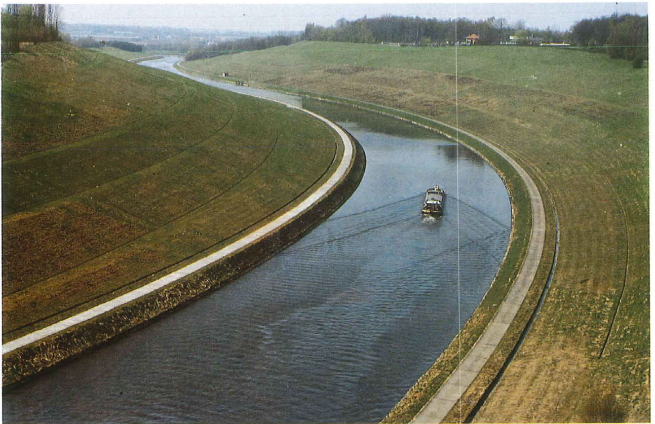
Fig. 144. Canal de Bruxelles à Charleroi, 1.350 t. Gouy-lez-Piéton. Entrée de la grande tranchée.
