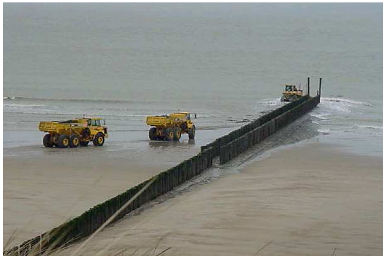
Uitvoering bestortingen aan strandhoofden
