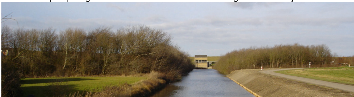
Figuur 7-1: gemaal Nieuwe Sluis en afwateringskanaal, polderzijde
