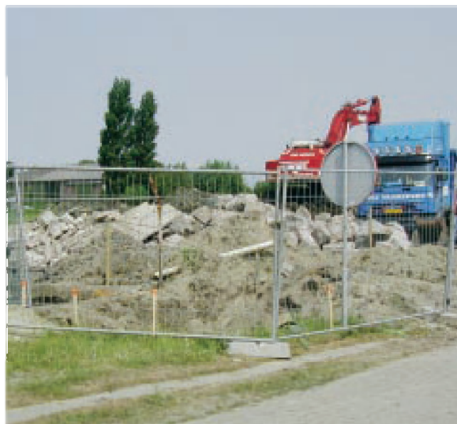
Bodemsanering gasfabriek Oostburg.
