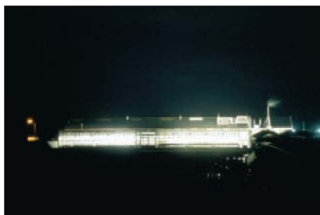
Nachtverlichting glastuinbouw Rilland.
