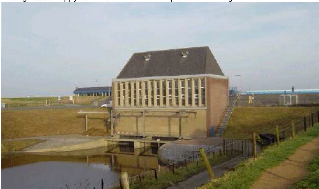
Foto Het gemaal te Cadzand-Bad
