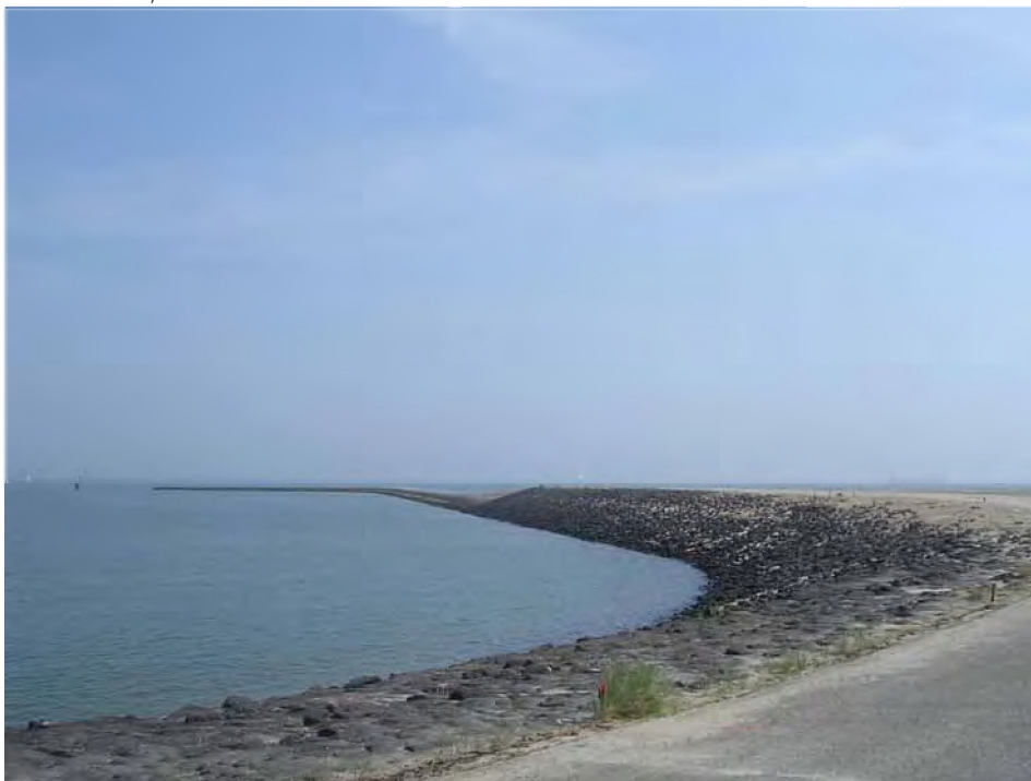
Foto De oostelijke dam van de Veerhaven.
