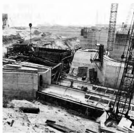
Constructie van de afvoerduiker aan de kant van het Kanaaldok.
