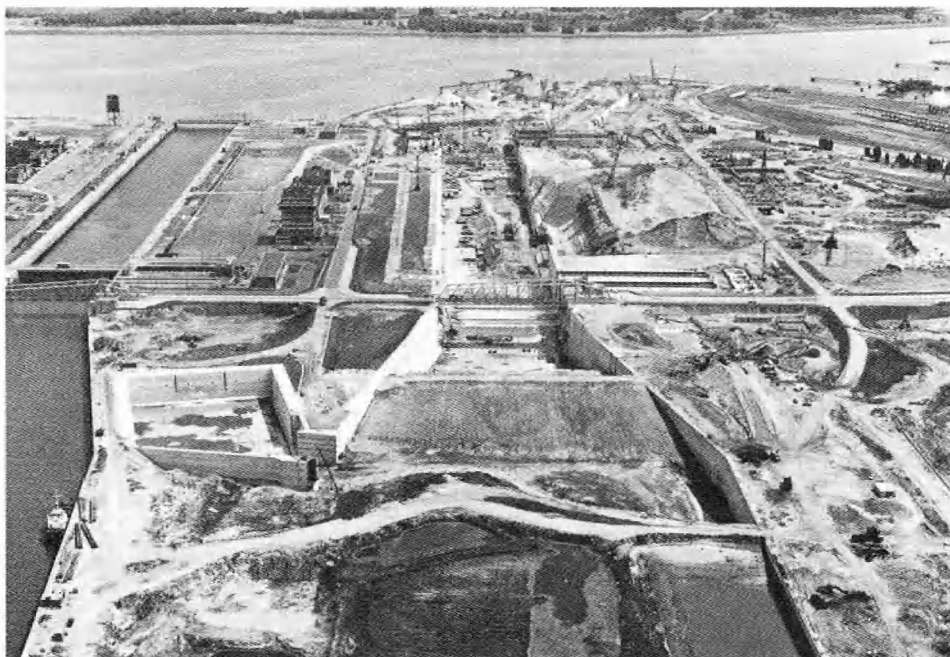
Stand van de werken aan de Berendrechtsluis midden 1986. Links op de foto de Zandvlietsluis. Op het voorplan de toegangseul met schuuldok voor sleeptoten.
