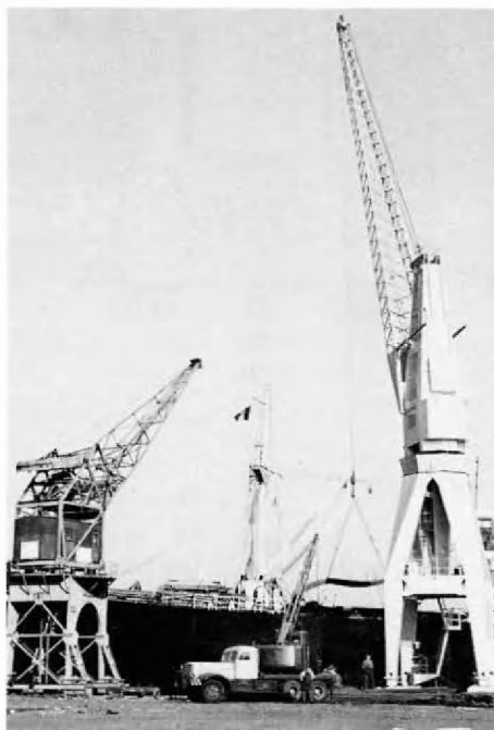
Schaalvergroting na W.O. II: twee elektrische topkranen aan het Leopolddok (Zuidkaai) in 1959. Links een M.A.N.-kraan uit 1928, 3 t x 6-18 m vlucht, toprol op 22-30 hoogte; rechts een Kocks-kraan uit 1958, 3 t tot 28 m en 5 t tot 20 m, toprollhoogte 41, 20-52, 50 m.
