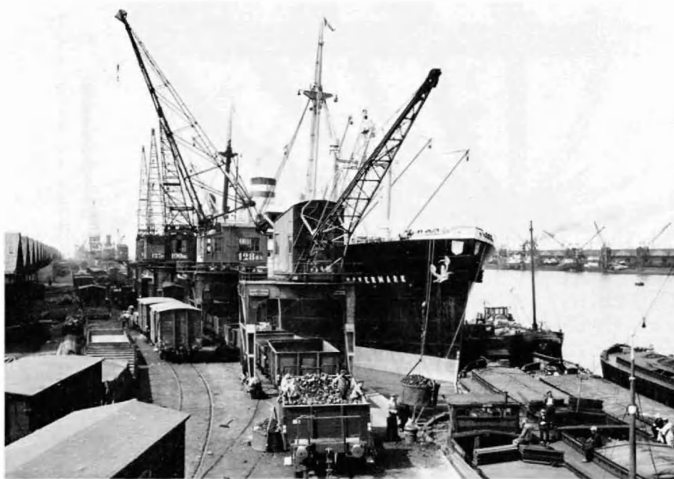
Tussen 1914 en 1945 doen stalen stoom- en motorschepen hun intrede, alsook de eerste tractoren. Verder verschijnen elektrische portaaltopkranen van 2,5 tot 8 t over één tot drie treinsporen, en de eerste elektrische laadbruggen van 15 t voor ertsen en kolen.
