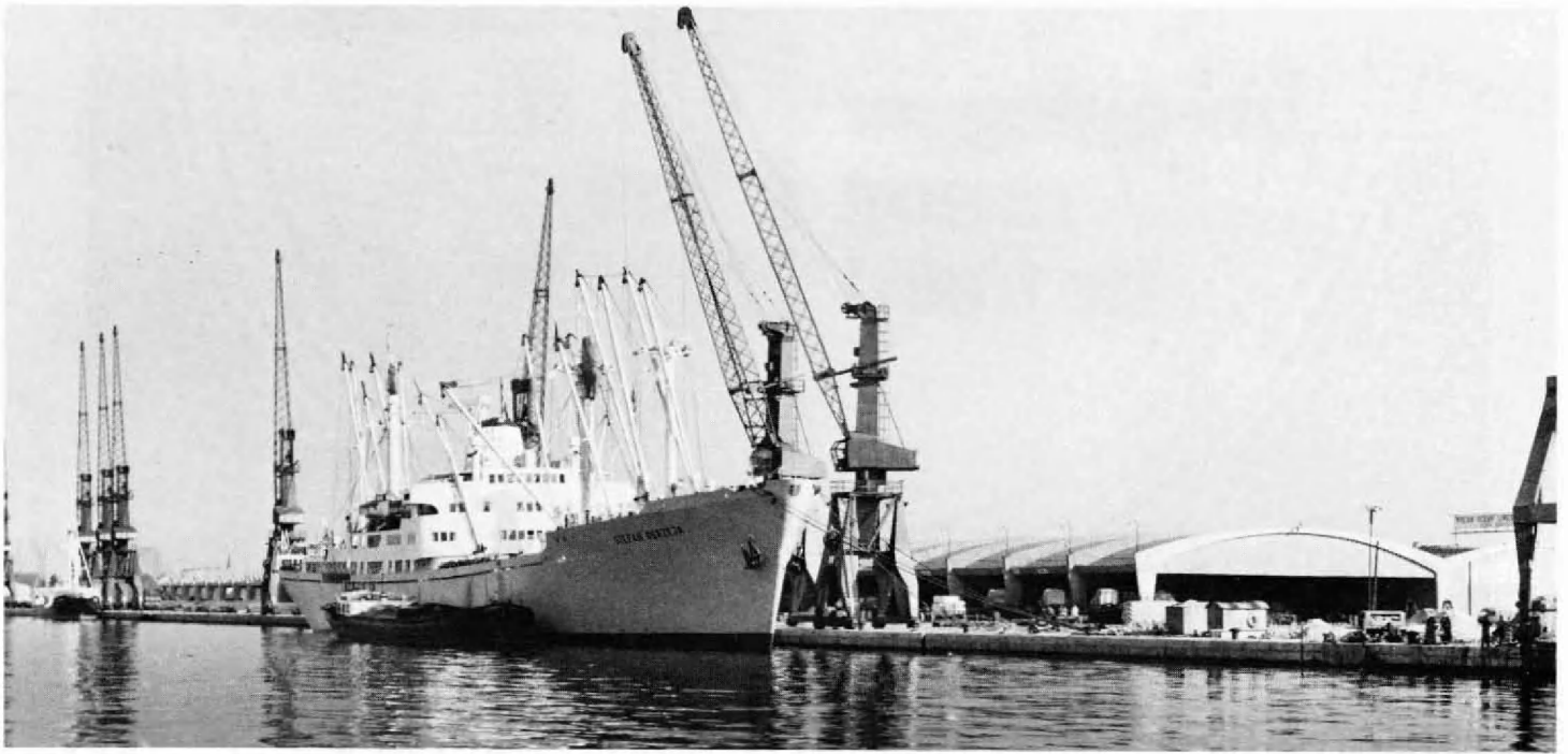
Van 1945 tot 1967 verrijzen afdaken in beton en elektrische portaaltopkranen van 3 of 5 t, over één of twee treinsporen, aan de steeds grotere dokken met zware kaaimuren. Vorkliften worden in gebruik genomen en belangrijke industriële bedrijven vestigen zich aan het water.
