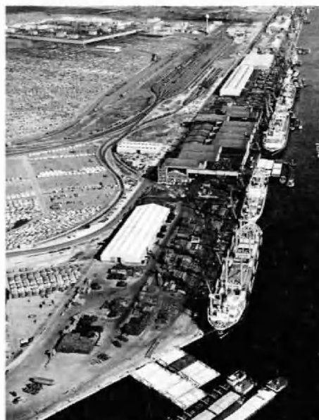
De bovenste foto toont de constructie van de gespecialiseerde steelterminal van Hessenatie aan de noordzijde van het Churchilldok in 1967. Daaronder wordt duidelijk geïllustreerd hoe dit havengedeelte verder werd uitgebouwd (linksboven op de foto de auto-assemblage plant 2 van General Motors).
