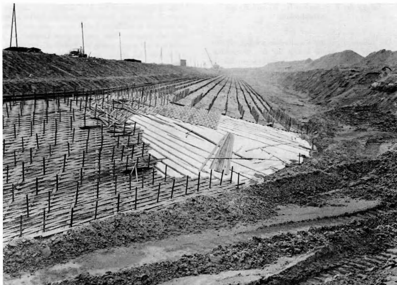
Uferschutz (in Ausführung) Oeverbescherming (in uitvoering) Protection de digue (en cours) Bank-protection (under construction)
