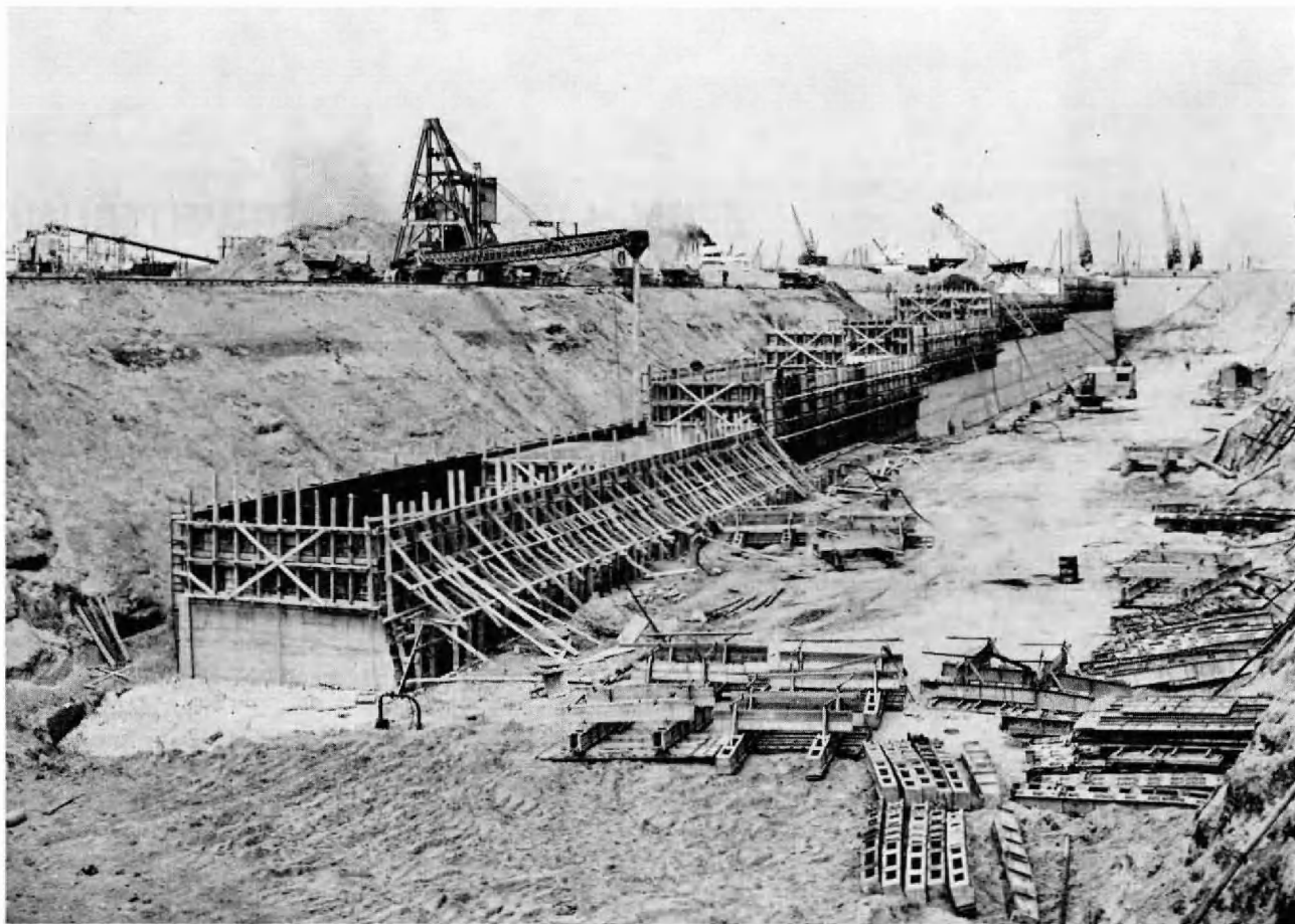
Bau einer Kaimauer (12.6.1958)
