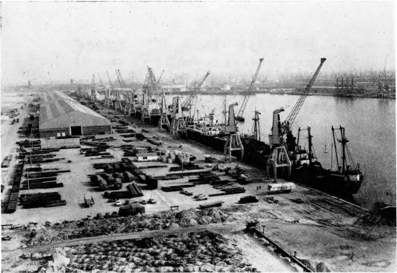
Ansicht vom 6. Hafenbecken; Gezicht op het 6de Havendok; Kräne mit 5 t Hubvermögen 5 t stukgoedkranen met 32 m mit einem Aktionsradius von reikwijdte. 32 m für Stückgüter.
