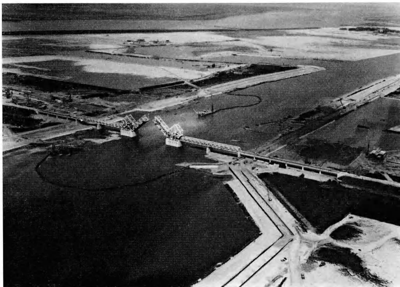
Aerial photograph Canal-Bridge Luchtfoto Kanaalbrug (8.6.1967)
