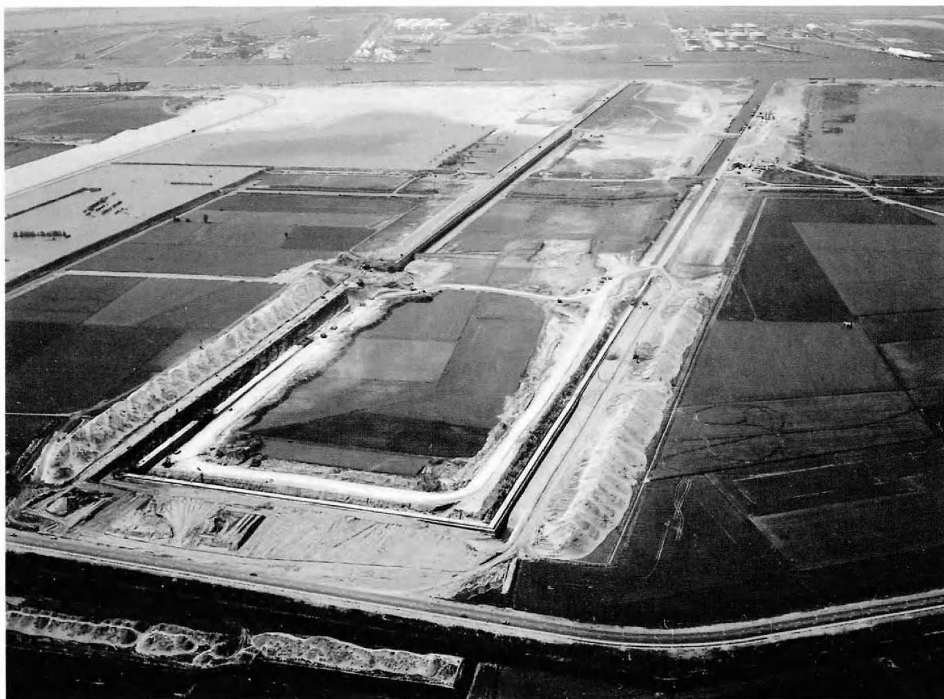
Foto : M B G (van de groep CFE) voert het derde en laatste deel uit van de betonnen kaaimuur rond het Delwaidedok
