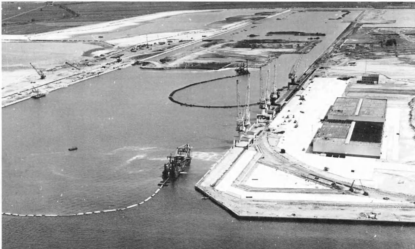
Figuur 5 : Uitbaggeren van het dok met twee cutterzuigers en hydraulische ophoging van de kaaivlakten rond het dok.
