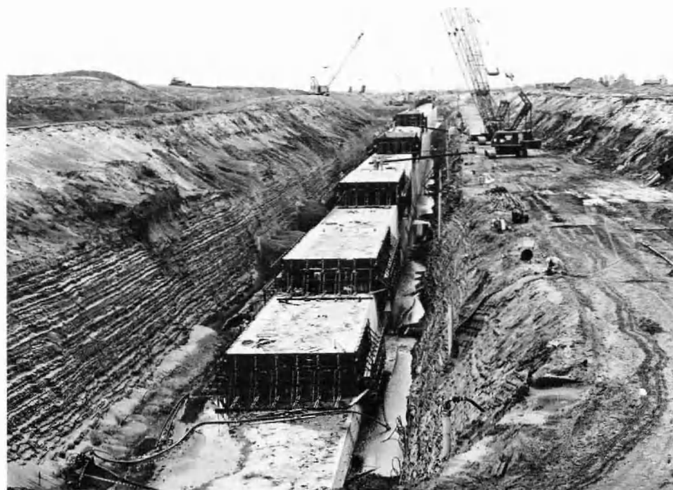
Figuur 3 : Opbouw van de massieve kaaimuur tijdens de eerste fase. In een bestendig drooggehouden bouwsleuf wordt de muur opgetrokken in moten van 20 m lengte en 2,70 m hoogte.
